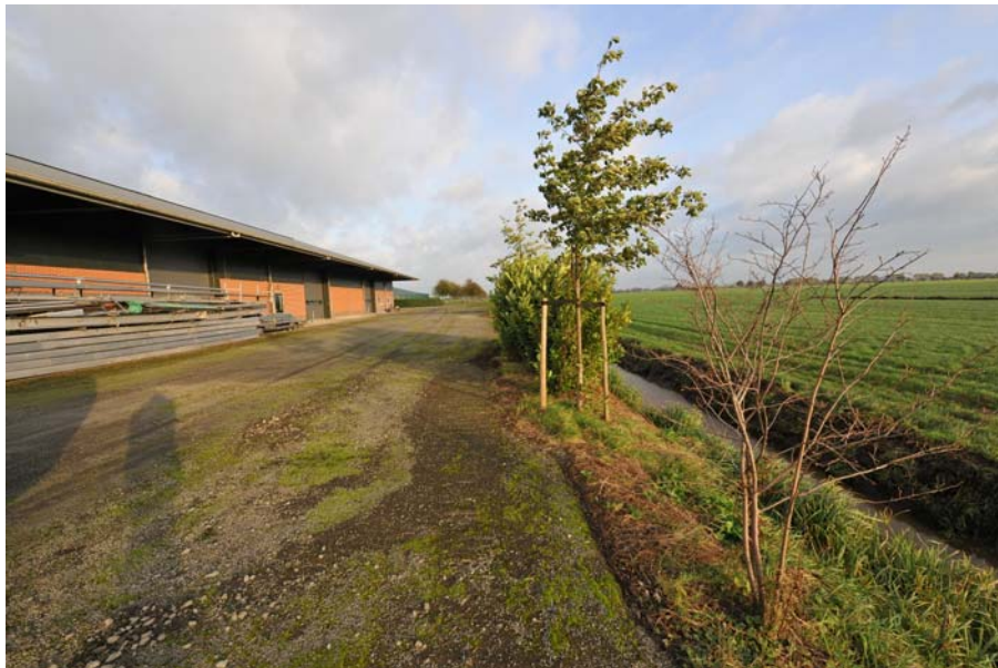
Schrale bufferbeplanting in een smalle taludstrook langs oostzijde perceel
