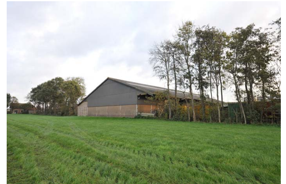
Westkant perceel, bestaande schuur niet ingekleed in bufferbeplanting
