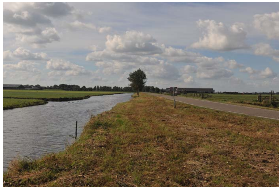
Kweldamweg in westelijke richting
