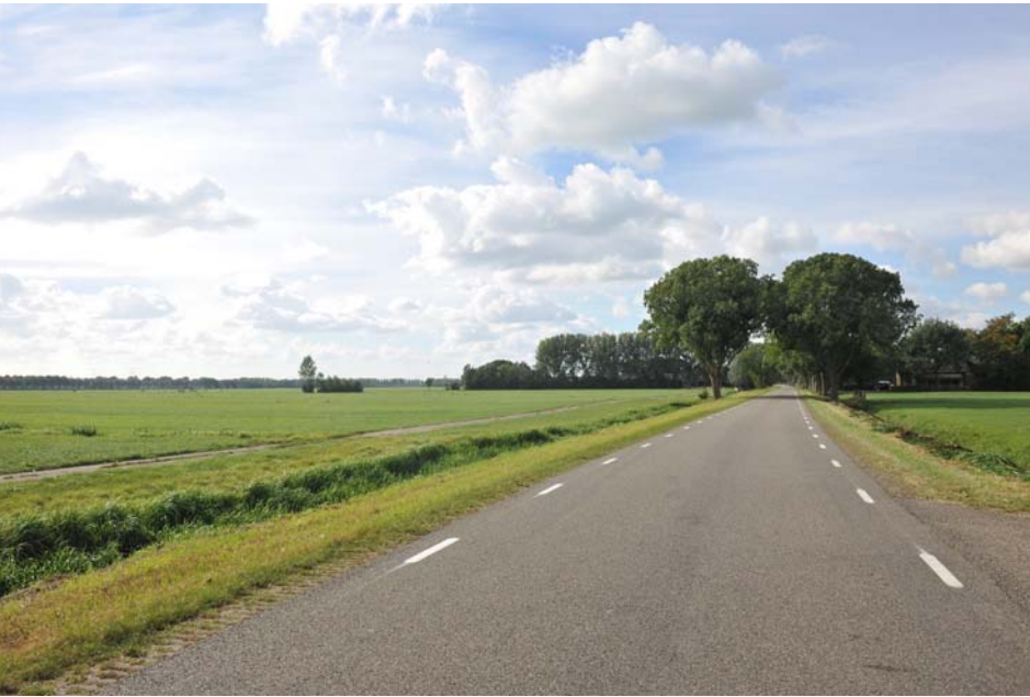
Kweldamweg 3 en 4 gezien vanuit oostelijke richting.
