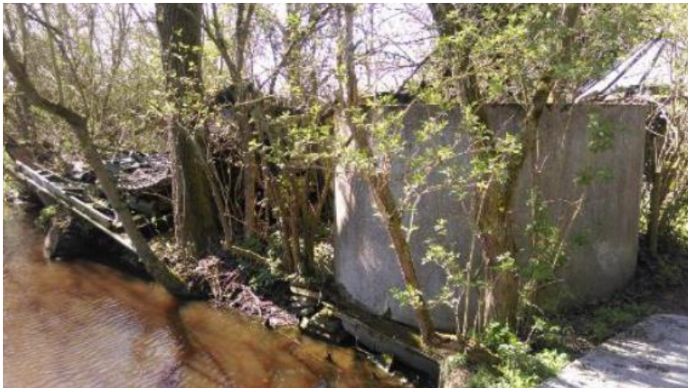
Afbeelding 2: Bestaande vervallen schuur en silo
