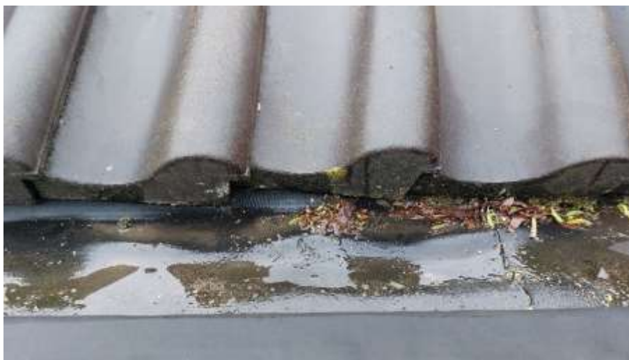
Figuur 4.4.1. Onder de onderste rij dakpannen is geen opening aanwezig die toegang verleent aan huismussen.
