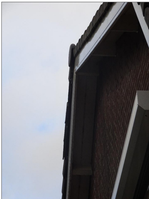
Openingen onder de kantpannen en kieren achter de dakoverstek van het woonhuis, geschikt voor vaste rust- en verblijfplaatsen van gierzwaluw en vleermuizen. Foto: M.M. Bouwmeester | Ecoresult B.V.
