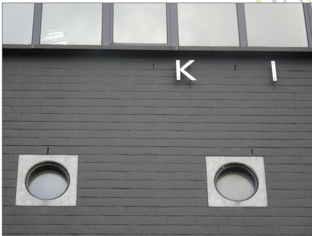
Open stootvoegen in de gevel van de Panoramazaal, geschikt voor vaste rust- en verblijfplaatsen van vleermuizen. Foto: M.M. Bouwmeester | Ecoresult B.V.
