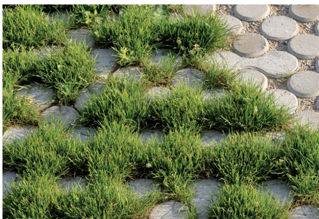
Grasbeton voor parkeren of verbreding rijstroken
