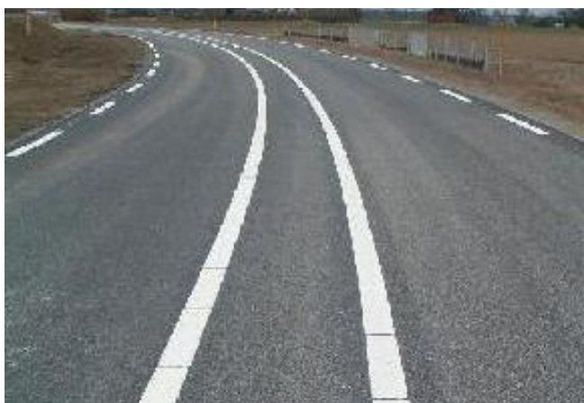
Asfalt op de Lekdijk
