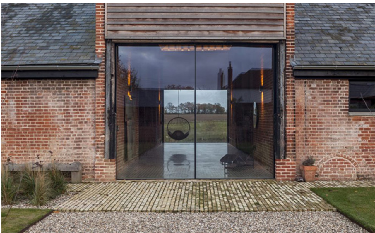
Referentie renovatie scheepsbouwoords: ingrepen zijn zichtbaar eigentijds (nieuwe tijdlaag)
