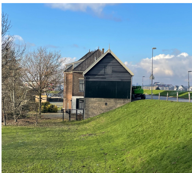
beleefbare hoogte van de dijk
