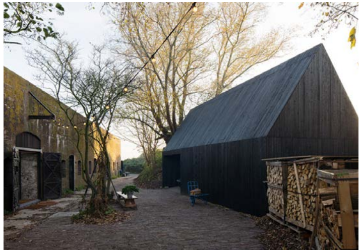
referentie bijgebouw bij fort Asperen
