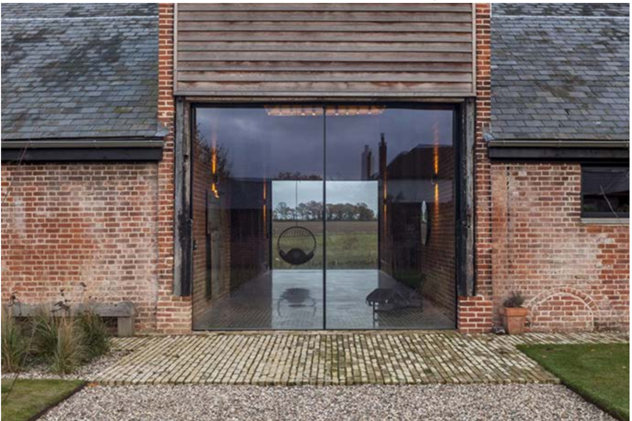
Referentie renovatie scheepsbouwloods: ingrepen zijn zichtbaar eigentijds (nieuwe tijdlaag)
