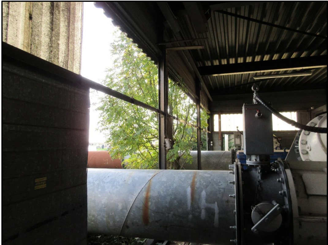
Figuur 2.3 De oostzijde van de timmerloods is bijna volledig open om doorgang te bieden aan de tijdelijke omleiding van de waterpompinstallatie vanuit het JU Smitgemaal.
