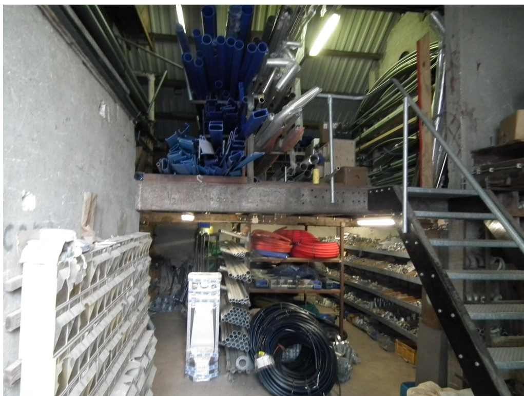
Figuur 2 De bebouwing betreft schuurtjes en opslaglocaties die bestaan uit vele aan- en uitbouwen aan elkaar. Het merendeel is opgetrokken uit damwanden en golfplaten.
