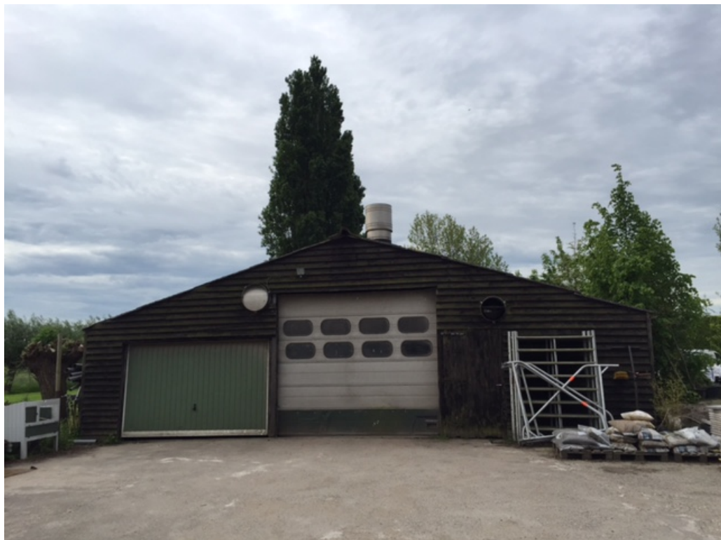
Figuur 4 De schuur achter de woning wordt gesloopt ten behoeve van de te realiseren woningen.
