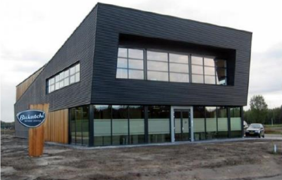
N5. Hoofdkantoor en showroom Bukatchi Hengelo Leferink Architecten bna
