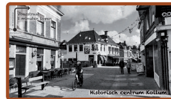
Plaatsen aansprekende verwijfsborden naar de Voorstraat
