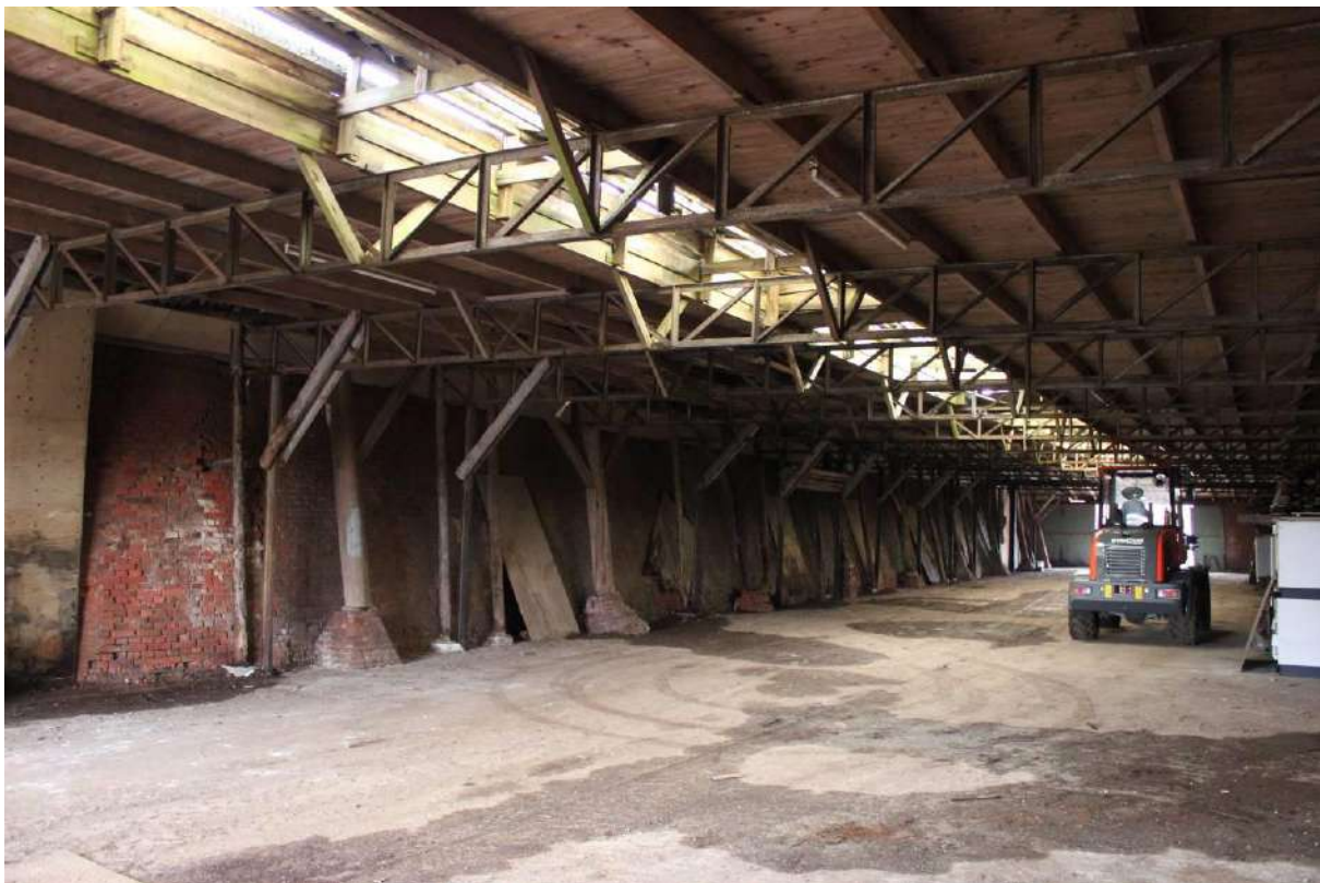
De noordgevel vanuit het oosten gezien. Deze gevelwand is de muur van de ringoven. De draagconstructie met de rondhouten standers en poeren is duidelijk aanwezig.
