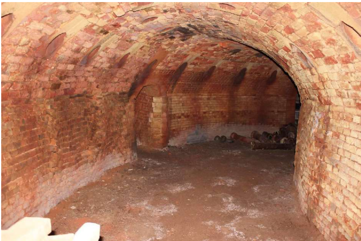
De binnenzijde van de ringoven. Richting oosten. Mooi in beeld zijn de diverse brandstoftoevoergaten en de rookgasafvoeren.
