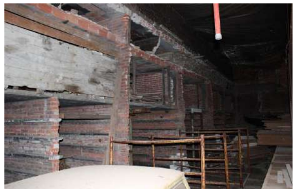
De halfgesloopte binnenzijde van de machinale drogerij uit 1961. De droogkamers met rekken zijn nog herkenbaar.
