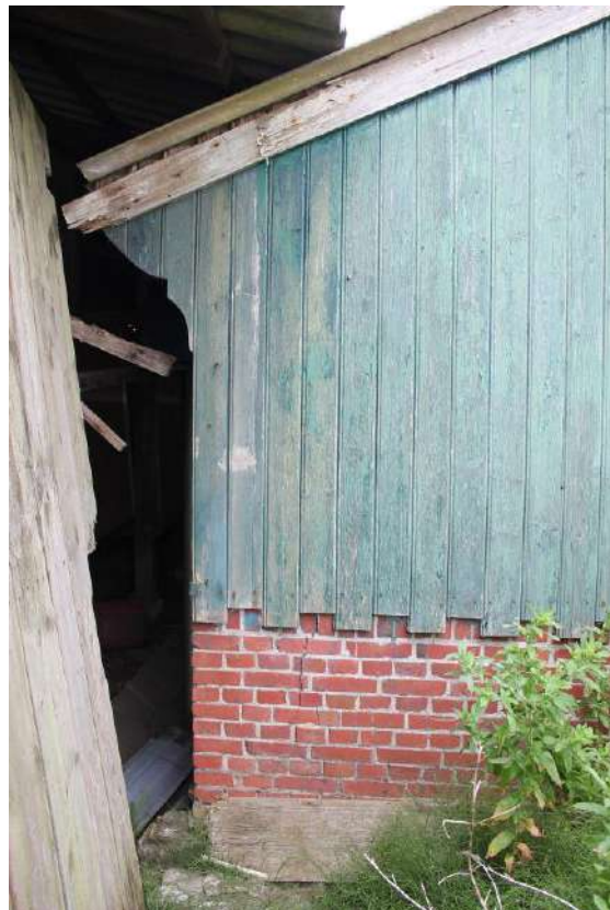
De detaillering van de oostelijke loods uit 1930.
