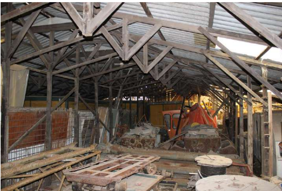
Interieur van de droogloods uit 1878 aan de westzijde
