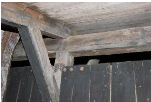
Droogloods Oost. Object 11. Gehakt telmerk I naast de aanzetting
