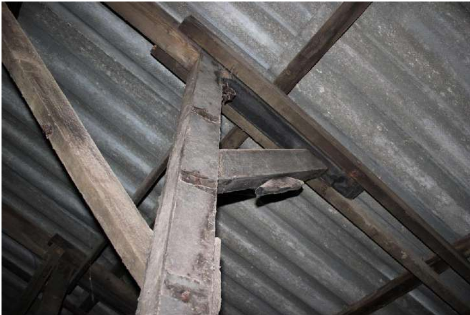
Detail van de stijl van de droogloods 1878. Aan de oorspronkelijke dakspoor zit het omgekeerd ojief.
