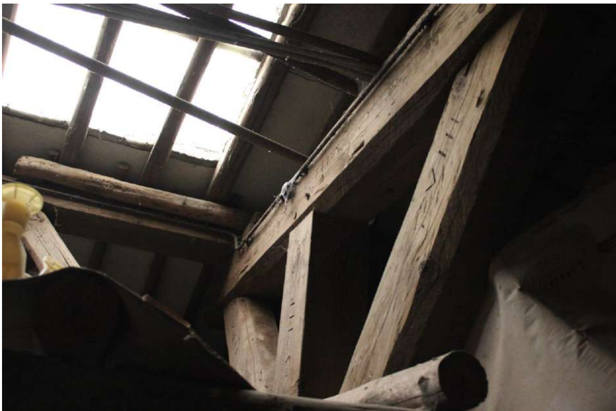
Dekbalkgebint 8. Alle onderdelen gehakte telmerken.
