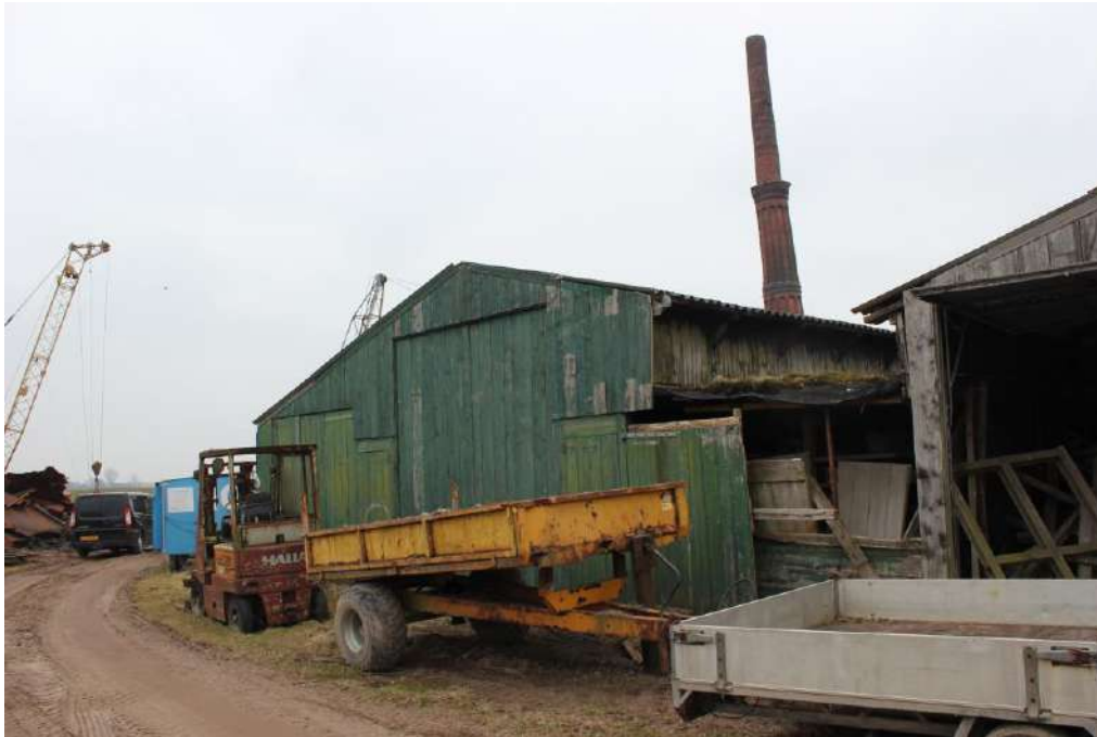
Droogloods 1915 aan de oostzijde. Het rechterdak (plat met begroeiing) is oorspronkelijk. Links is het dakvlak in het verlengde van het zadeldak aangepast.
