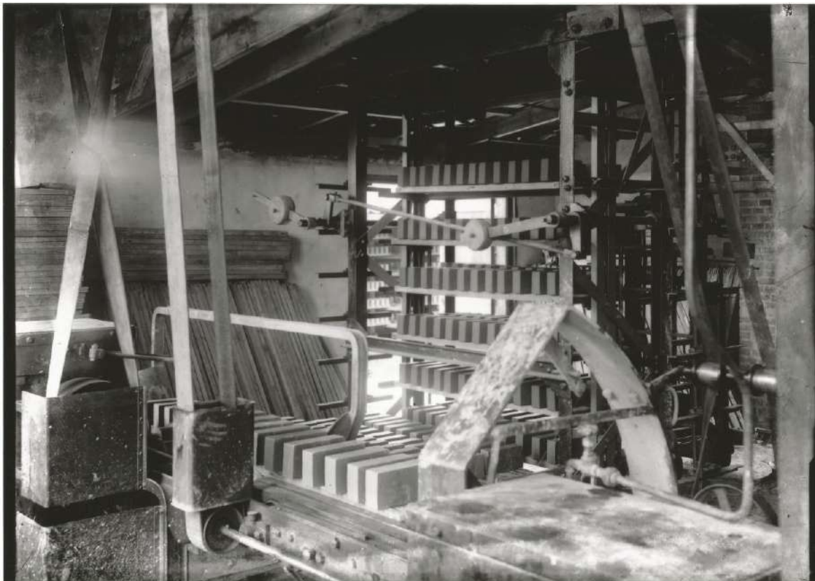
Afbeelding 13. De strengpers waar de stenen worden gevormd. Bron: Bert Kooistra.
