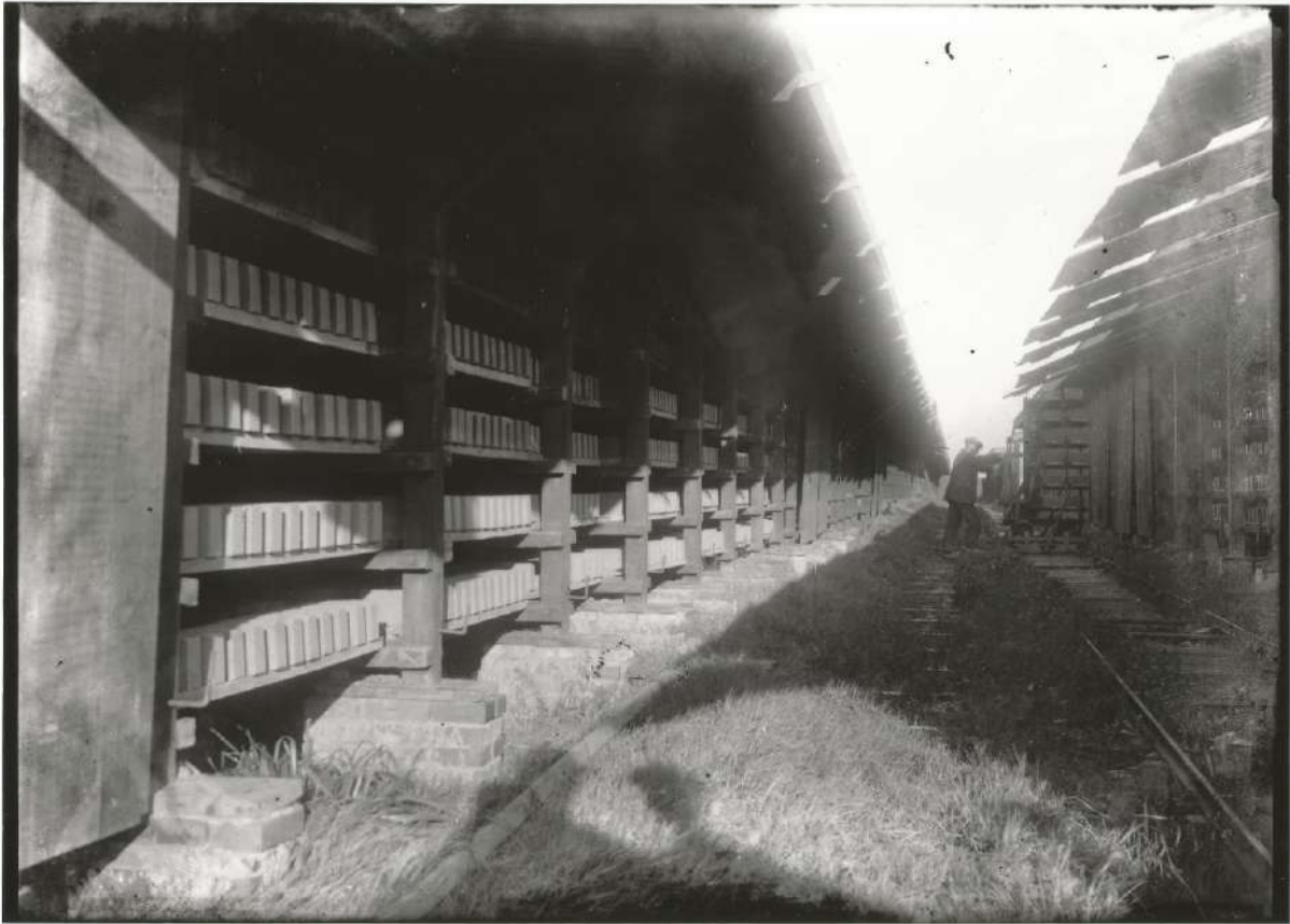
Afbeelding 12. De afzetwagen van Keller tussen twee droogloodsen in. Rechts is de loods met verhoogd middendeel uit 1915. Links de loods uit 1878. Bron: Bert Kooistra.
