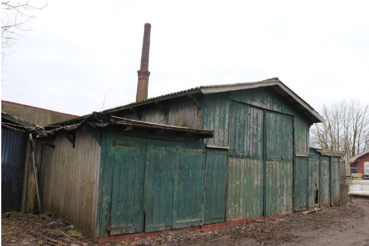
De westgevel van de droogloods uit 1915. De lage deuren in de zijvlakken zijn nog origineel.
