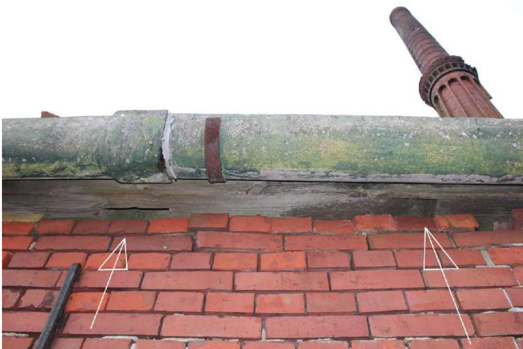
De onderzijde van de muurplaat laat sporen zien van de ondersteuningsconstructie die het overstek droeg. Waarschijnlijk gewijzigd in 1879. De witte pijlen geven de pen- en gatverbindingen aan. Van zowel staander als korbels.
