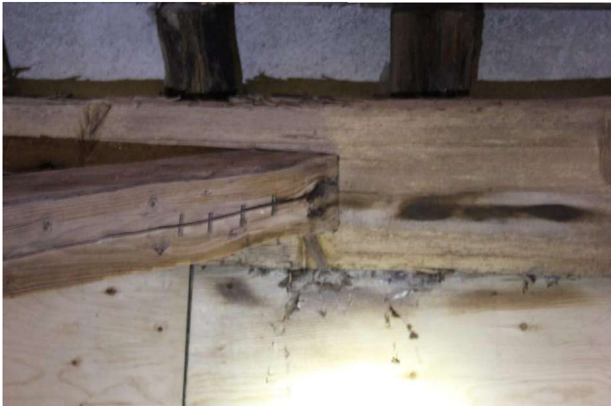
Een van de korbelen bij een rondhouten staanders gemerkt met een gehakte IIII.
