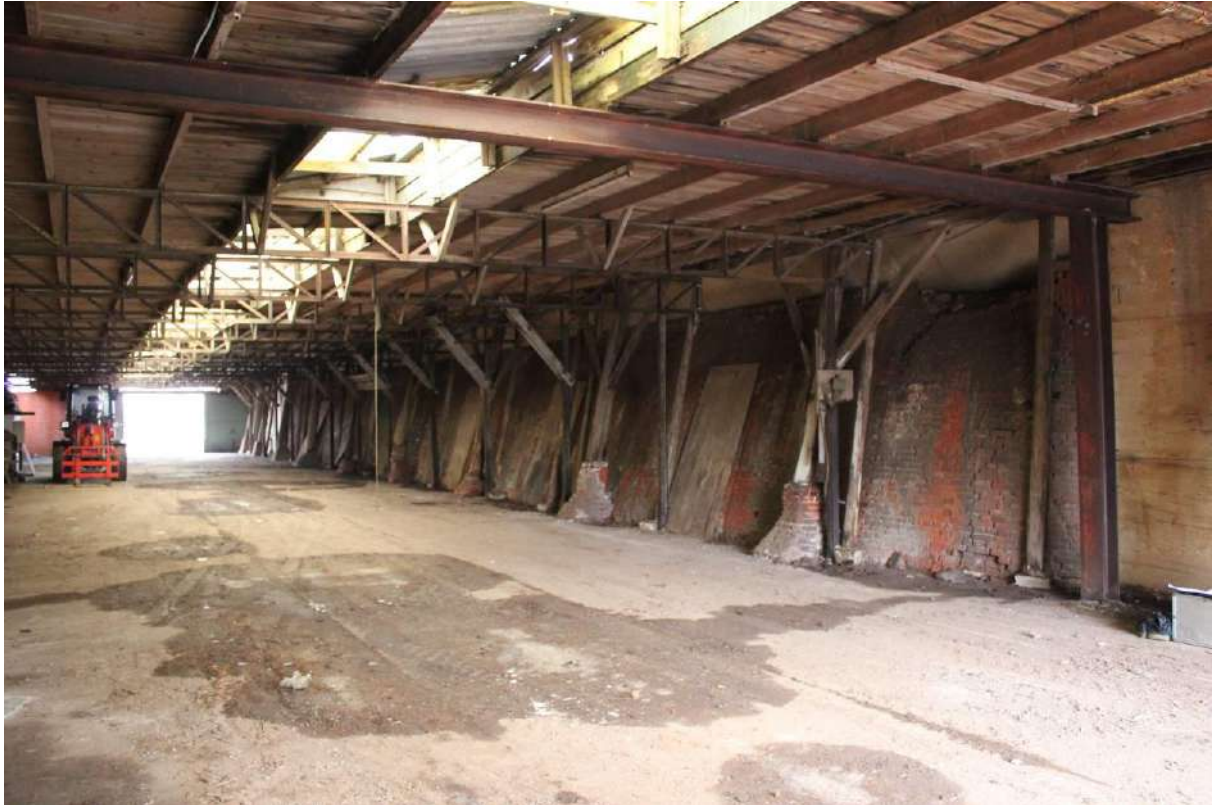
De noordgevel. Deze gevelwand is de muur van de ringoven. De draagconstructie met de rondhouten standers en poeren is duidelijk aanwezig.
