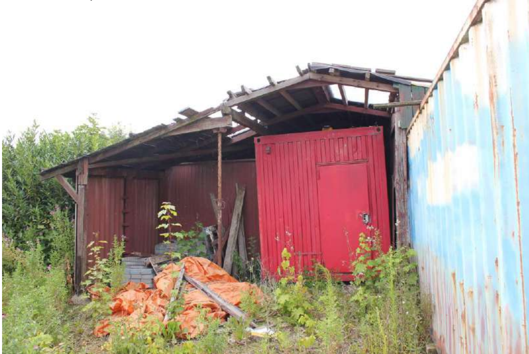
De oostgevel van object 16. Verscholen achter heggen, containers en woningen.
