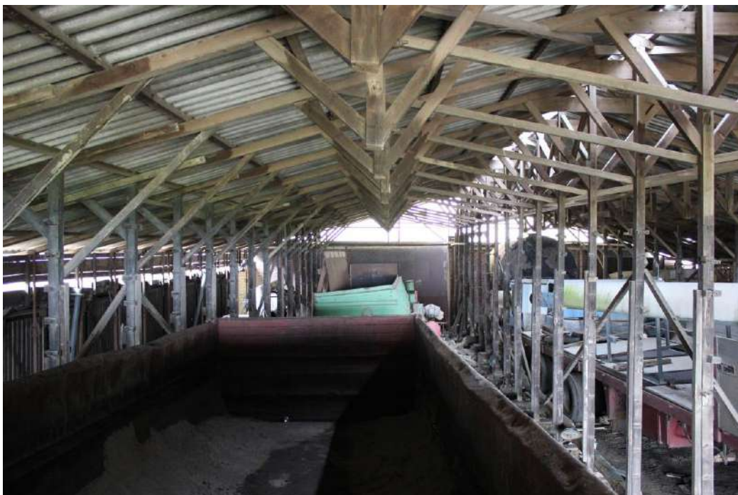
De binnenzijde van loods uit 1878. Hier is de constructie met de verhoging goed zichtbaar. Links de loods uit 1915 object 5.
