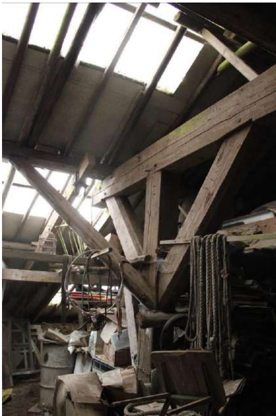
Stijl en korbelen van dekbalkgebint met telmerk II.
