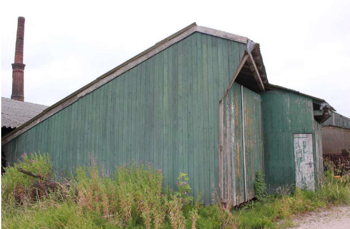
De oostgevel van de loods uit 1930. De hoek is duidelijk ingekort.
