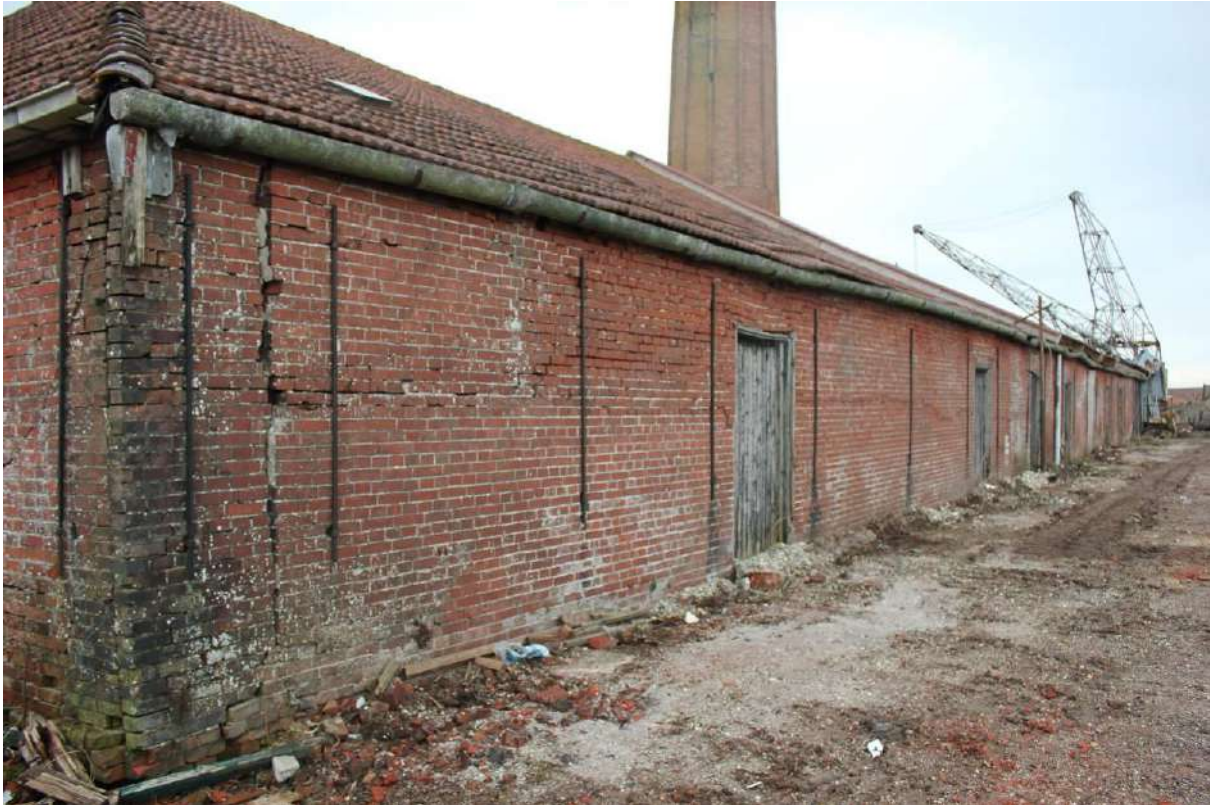
De zuidelijke gevel aan het Dokkumer Grootdiep. De onderste lagen metselwerk zijn opgetrokken in staand verband. De rest is uitgevoerd in kruisverband.
