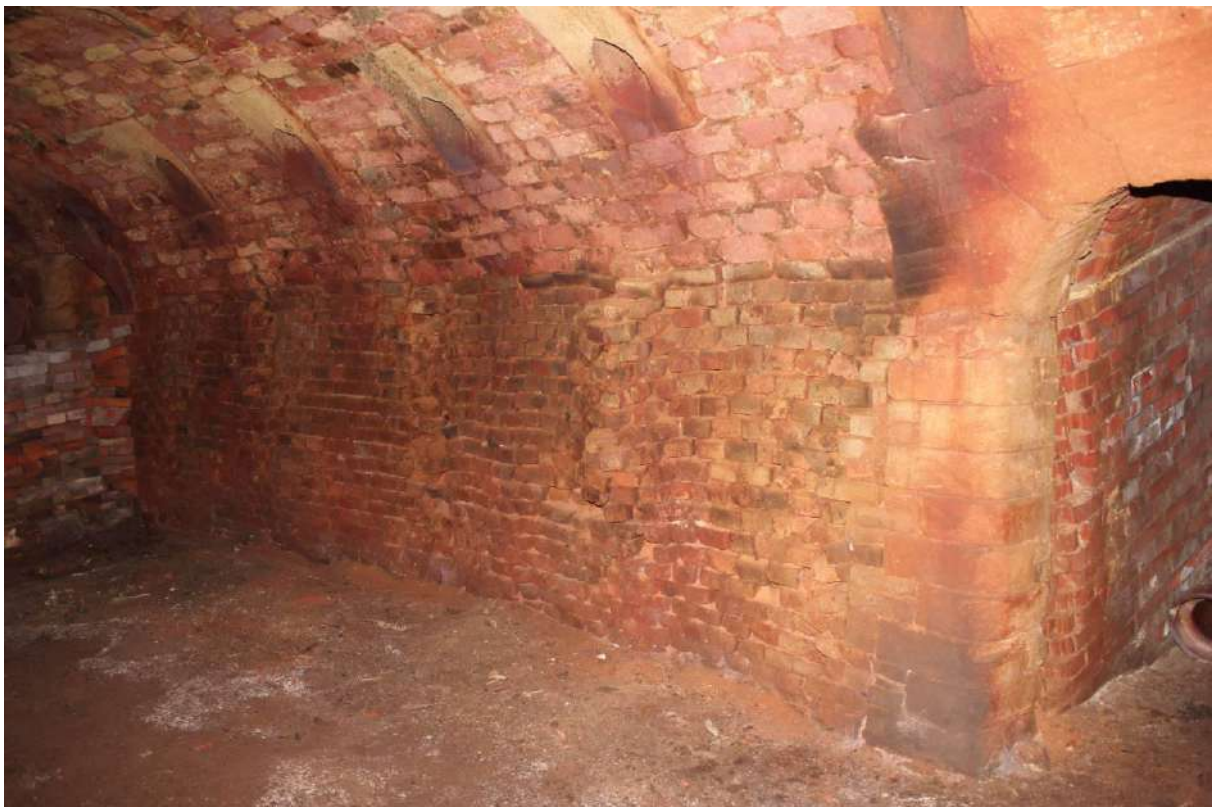
De binnenzijde van de ringoven. Rechts in beeld is weer een ingang. Hoek- en sluitoplossing gemaakt van natuursteen.
