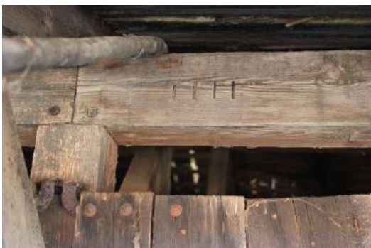
Droogloods Oost. Object 11. Gehakt telmerk IIII naast de aanzetting
