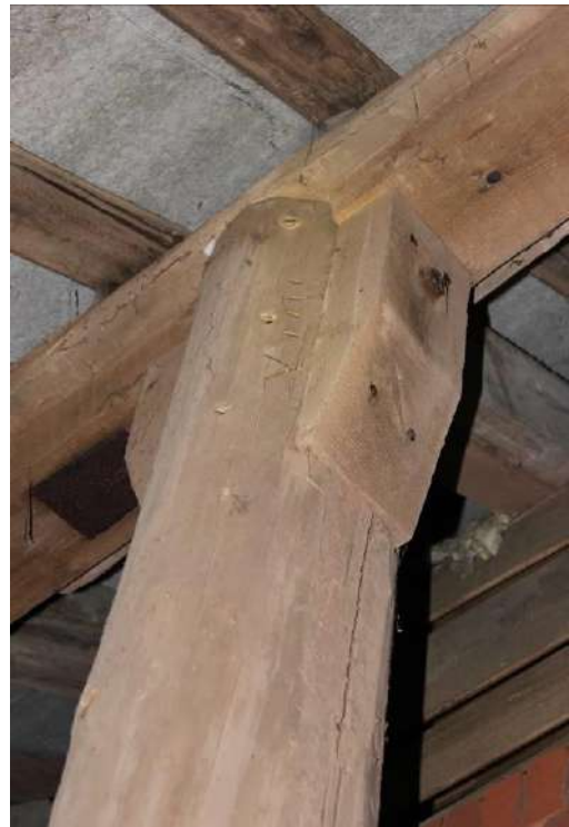
De rondhouten staanders gemerkt met een gehakte V aangevuld met gegutste ()()()() maakt Merk 9
