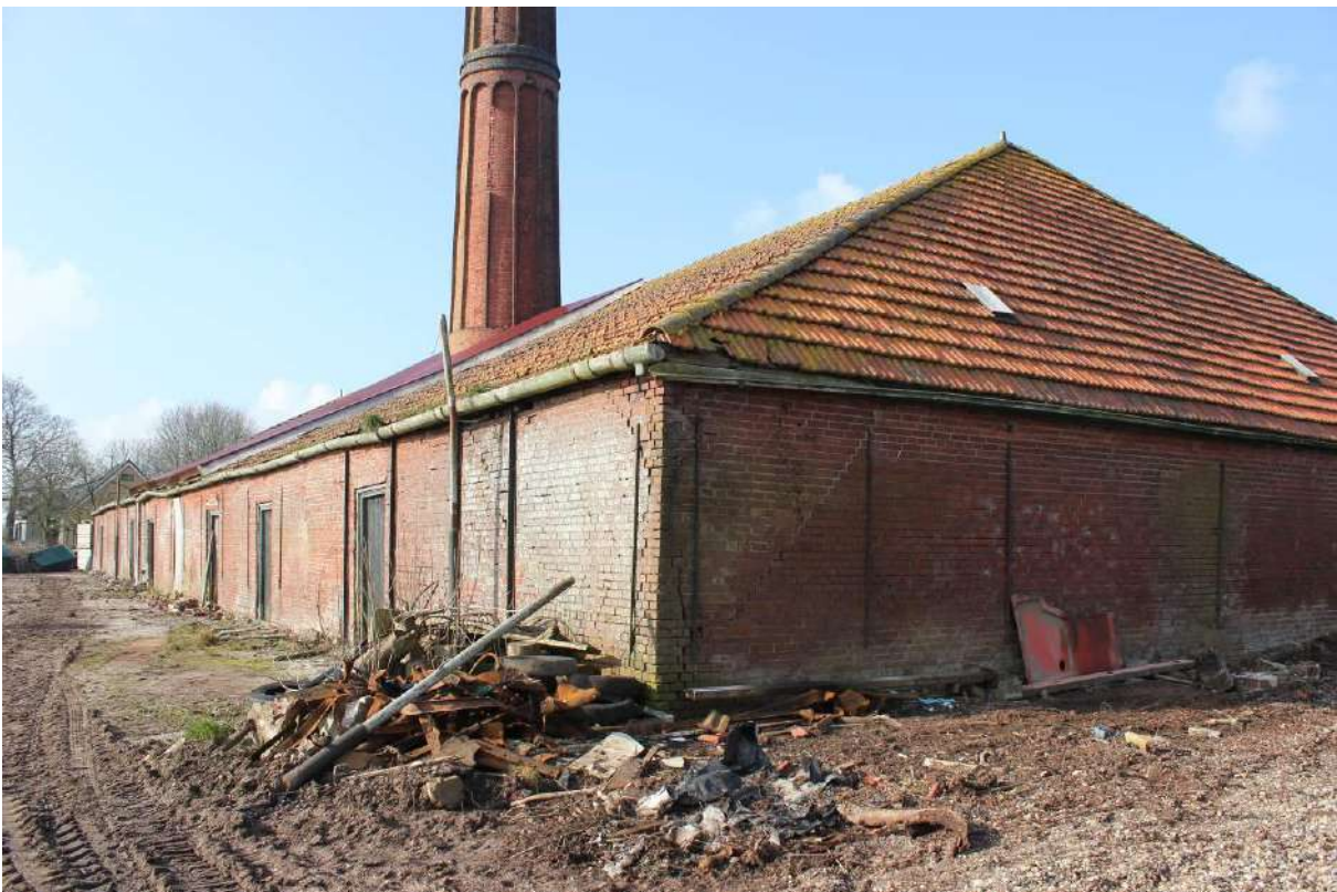
De zuidgevel met rechts een stukje oostgevel. Opvallend zijn de lange muurankers.
