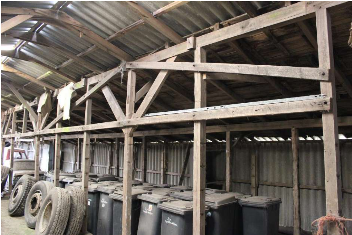
De gebintstellen constructie van loods. Object 15.
