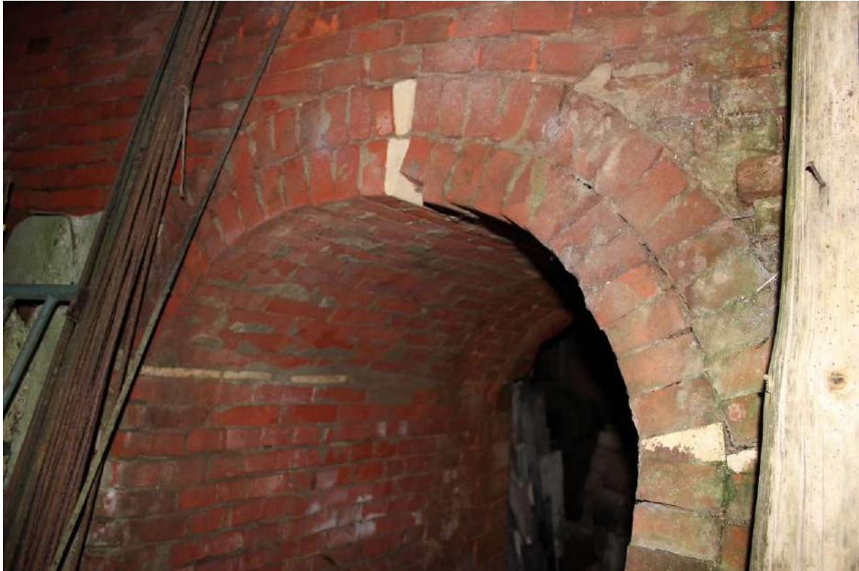
Een van de ingangen van de ringoven aan de zuidzijde. De rondboog is gemetseld met witte aanzet- en sluitsteen.
