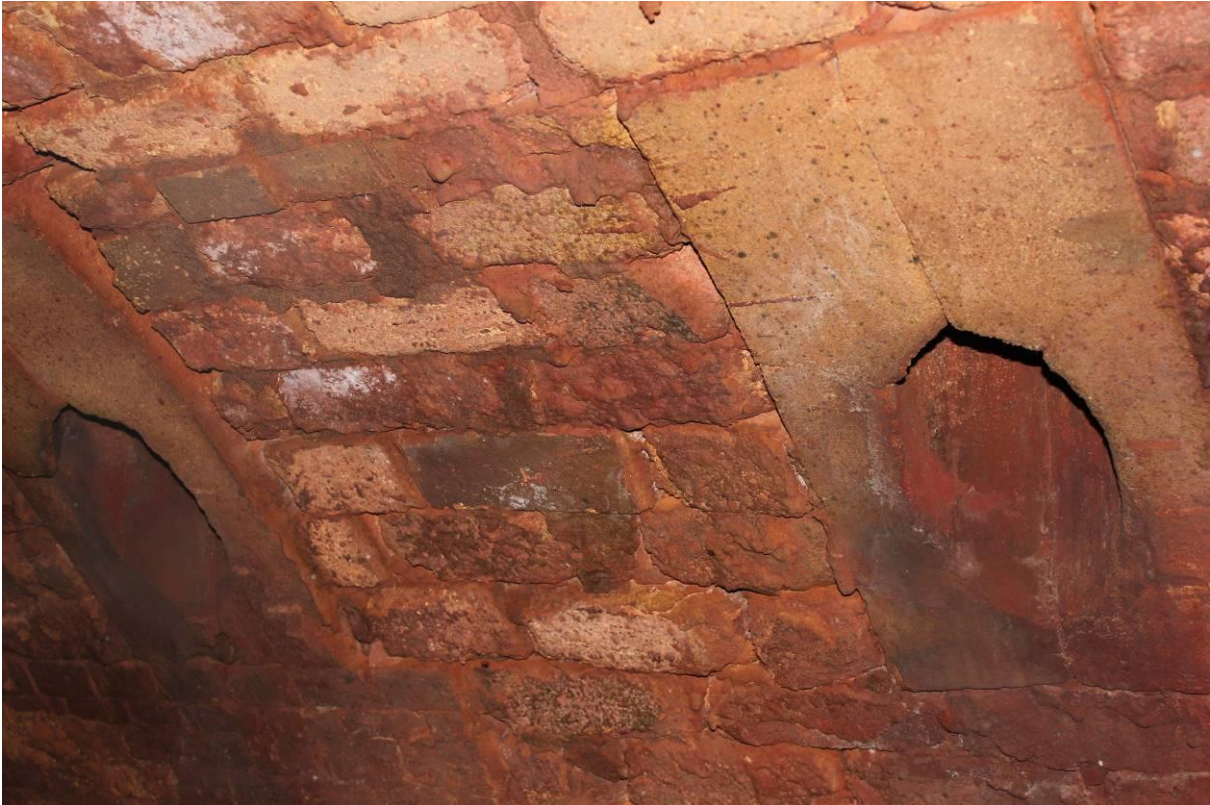
De binnenzijde van de ringoven. Geprefabriceerde blokken vormen de doorvoeren door de ovenwand.
