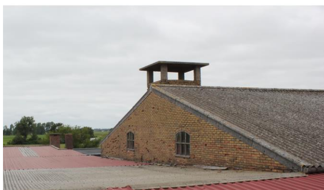
De topgevel van de machinale drogerij aan de westzijde.
