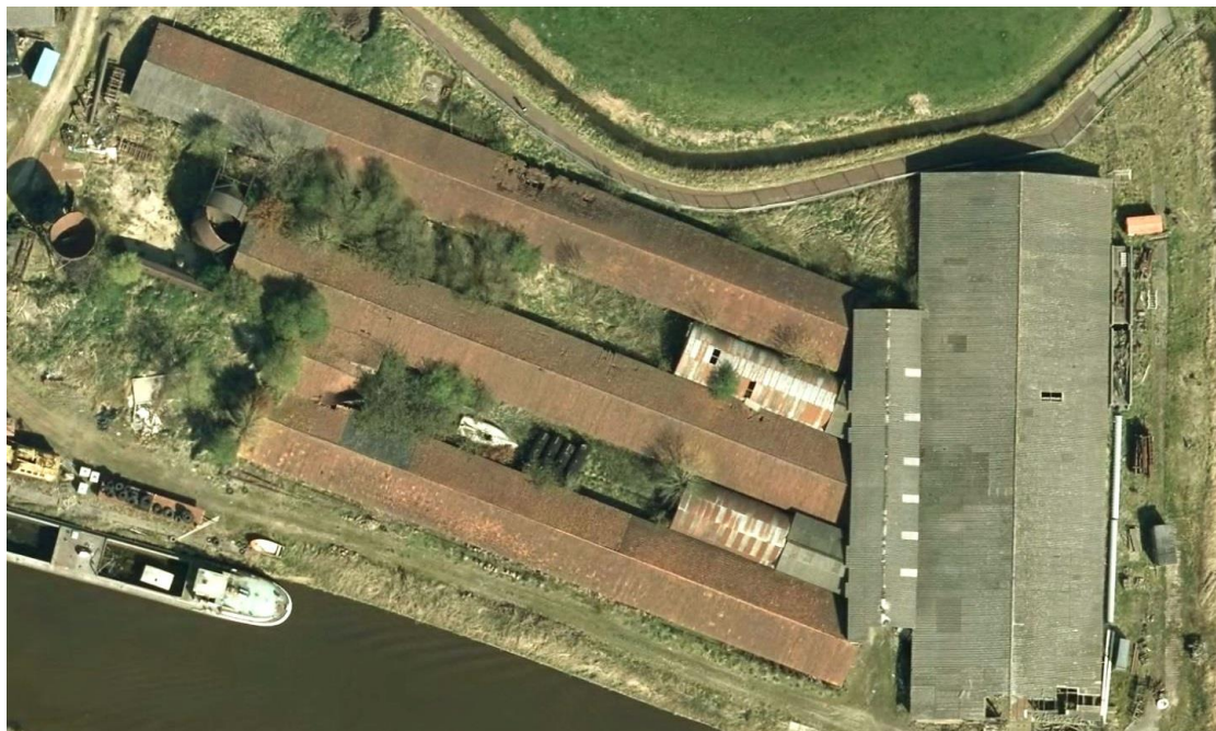
Luchtfoto van de droogloodsen oostelijk van de fabriek. Boven droogloods 10, in het midden loods 11 en onder droogloods 12. Geheel rechts de grote droogloods object 23.
