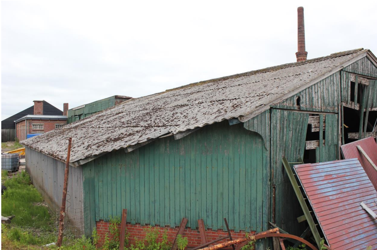
De loods met schuine deel. Gebouwd in 1930. Detaillering idem object 3.
