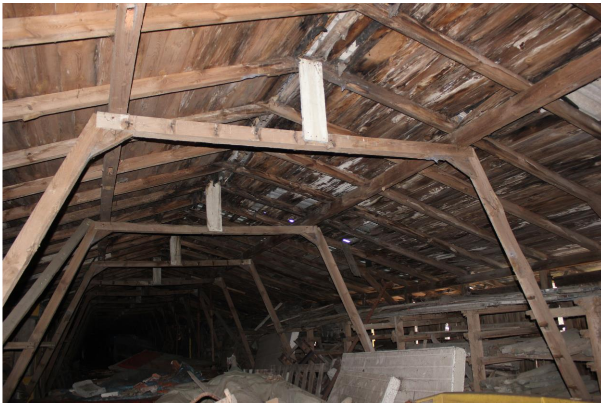
De binnenzijde van loods object 10 aan de meest oostelijke zijde. Hier is de ondersteunende constructie van de loods helemaal summier uitgevoerd. Links zijn de droogrekken te zien.
