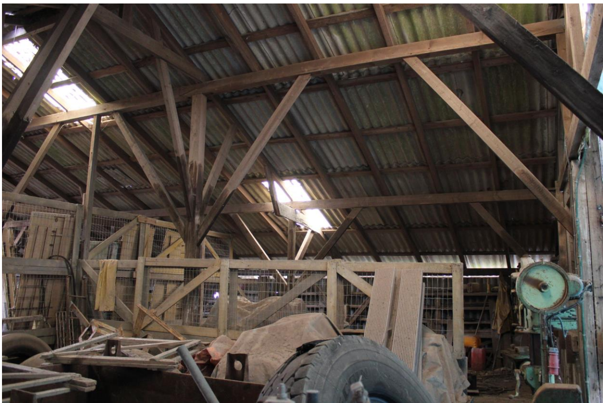
Interieur van de loods uit 1930 met schuine deel.
