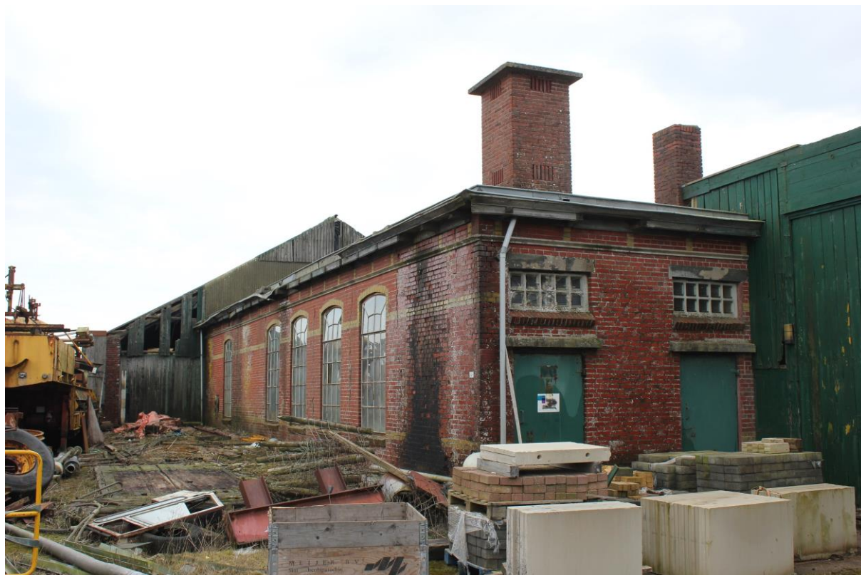
Het ketel- en machinehuis met het uiterlijk van 1913. Het voorste deel is de aanbouw van de P.E.B. uit 1946
