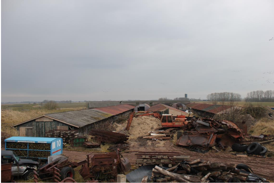
Overzicht droogloodsen oostelijk van de fabriek. Links droogloods 10, in het midden loods 11 (achter de kraan) en rechts droogloods 12.
