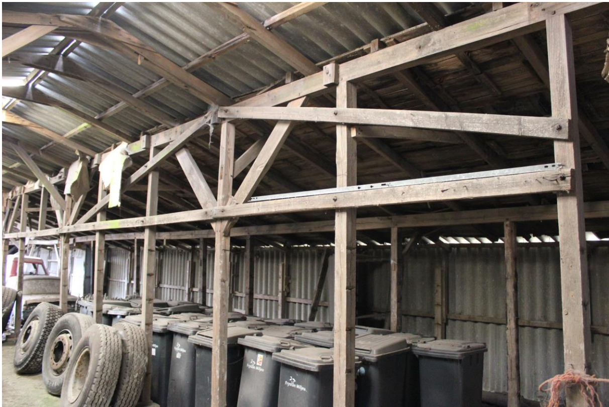
De gebintstellen constructie van loods. Object 15.
