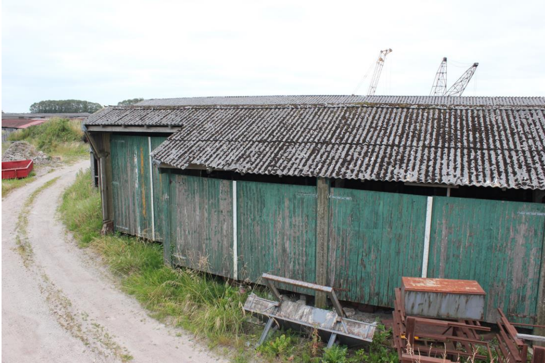
De noordgevel van de loods uit 1930. Grote houten deuren domineren het beeld.
