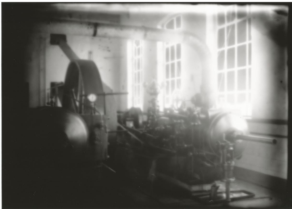
Afbeelding 14. De stoommachine in het ketel- en machinehuis. Bron: Bert Kooistra.
