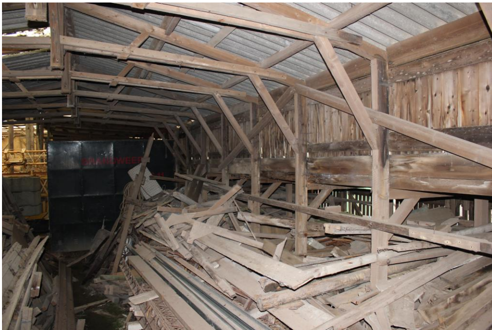
De binnenzijde van loods uit 1915. Hier is de constructie van het verhoogde middendeel goed zichtbaar. Rechts zijn de bovenluiken te zien.
