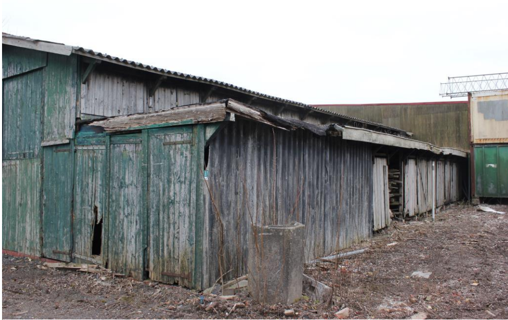
De buitenzijde van loods uit 1915. Hier is de constructie van het verhoogde middendeel goed zichtbaar. In het verhoogde middendeel zijn de bovenluiken te zien.
