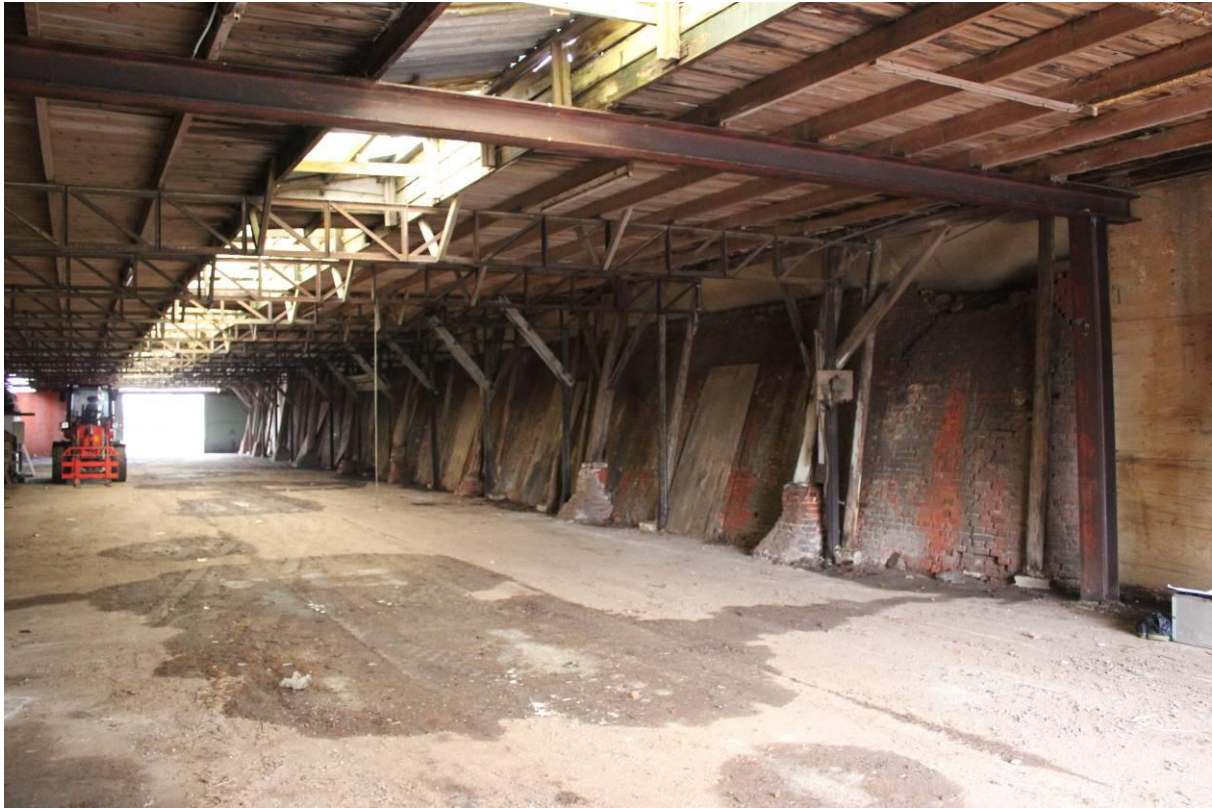
De overkapping naast de ringoven. Stalen vakwerkliggers dragen het platdak.
