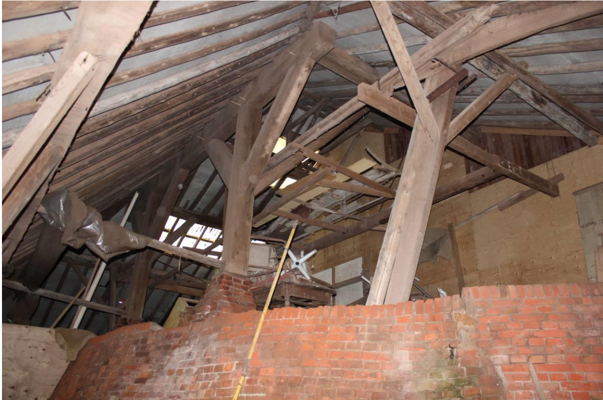
De dekbalkgebintconstructie boven de ringoven. Hier staat het meest westelijke dekbalkgebint met overstekken. De stijlen staan op gemetselde poeren.
