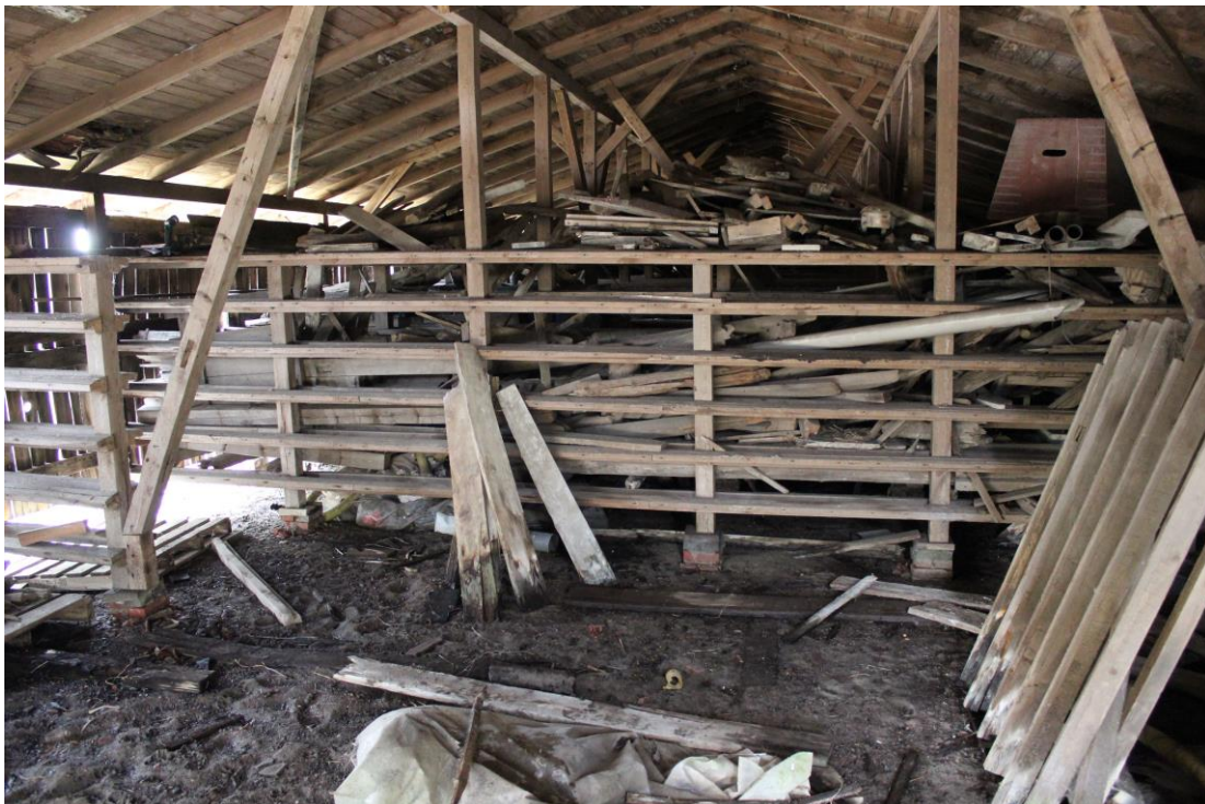
Interieur van droogloods uit 1922. Hierin zijn nog originele droogrekken aanwezig.
