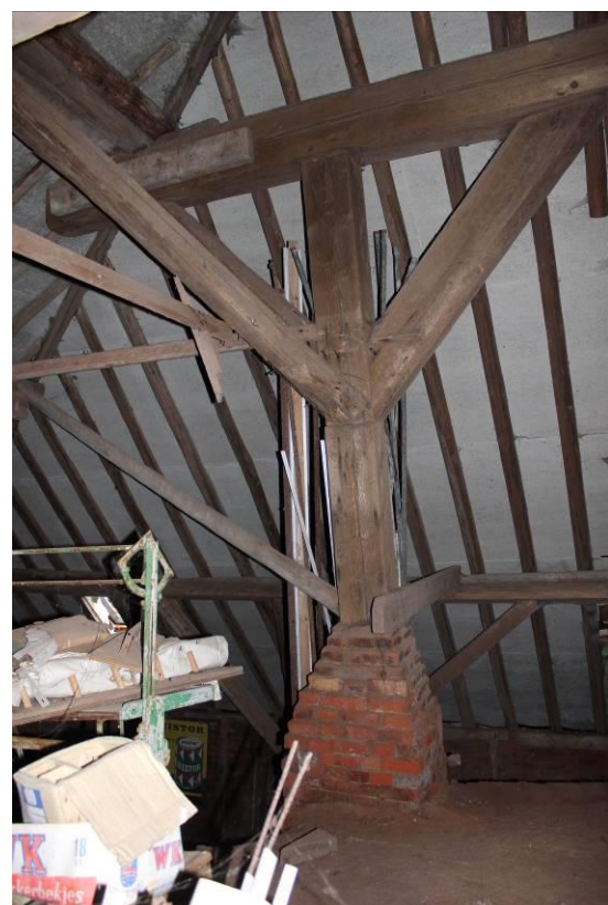
Het meest oostelijke dekbalkgebint. Gemerkt met een III
