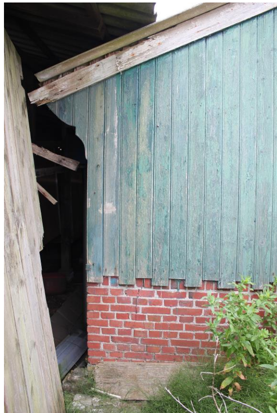
De detaillering van de oostelijke loods uit 1930.
