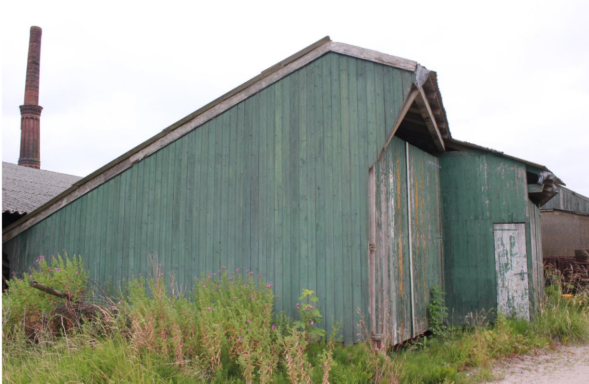
De oostgevel van de loods uit 1930. De hoek is duidelijk ingekort.
