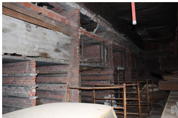
De halfgesloopte binnenzijde van de machinale drogerij uit 1961. De droogkamers met rekken zijn nog herkenbaar.
