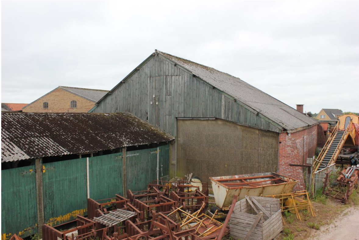
Object 2. Hoge loods aan de oostzijde van het ketel- en machinehuis.
