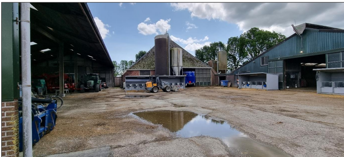
Afb 4: Achterzijde van de schuur
