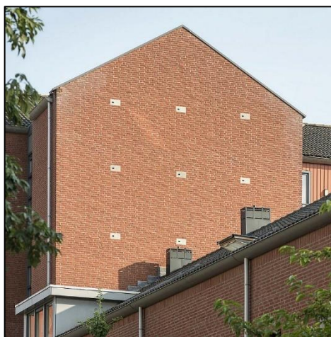
Afb 14 + 15: Gierzwaluwkasten ingemetseld (worden ook gebruikt door Huismussen)
