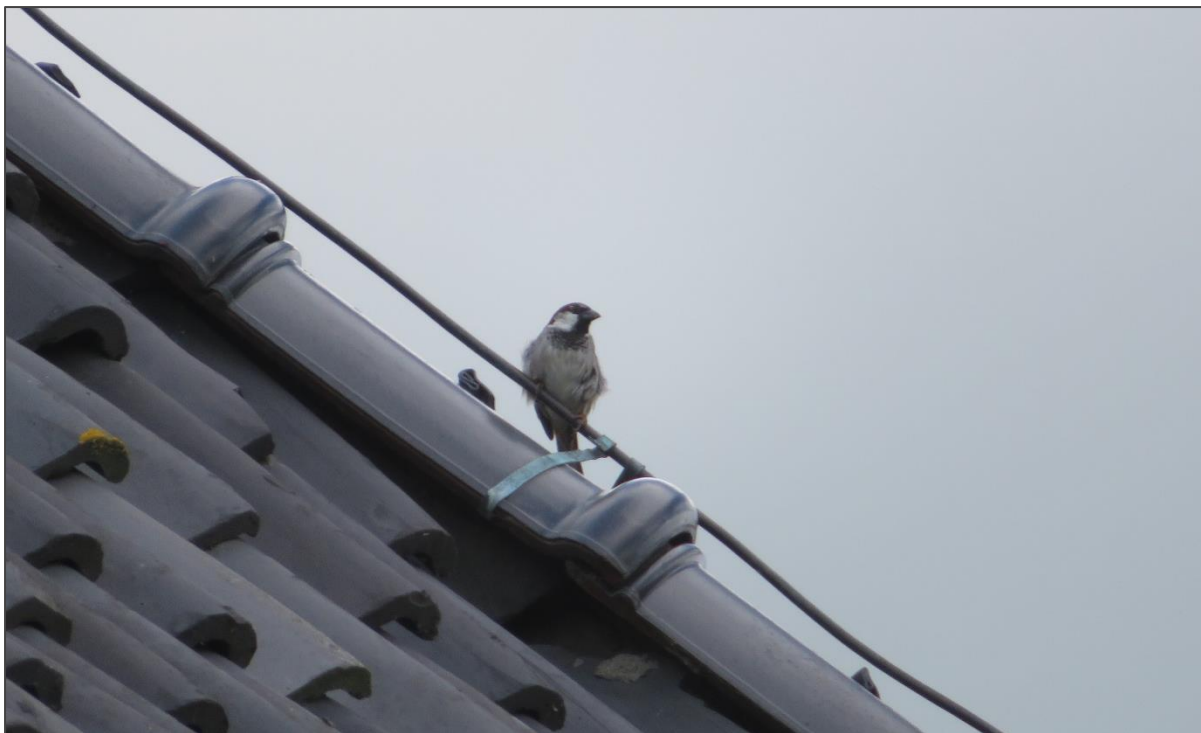
Afb 9: Huismus. Er is ter plekke mogelijkheid om onder de hoekpan te komen
