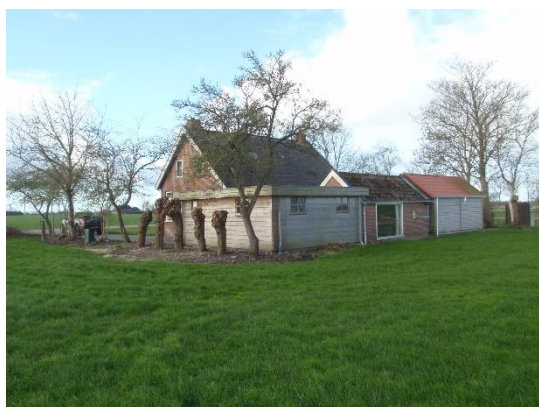
Figuur 3 zij aanzicht woonhuis met aanbouw
