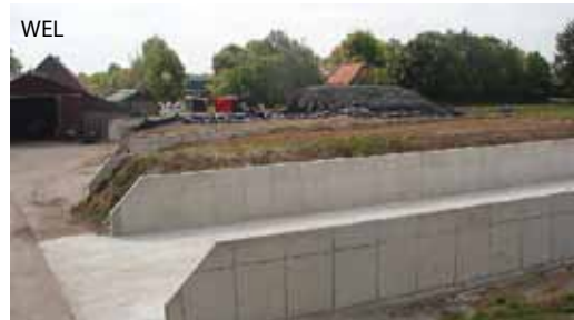
Sleufsilo's op het achtererf
