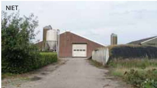
Sleufsilo's op het voorerf
