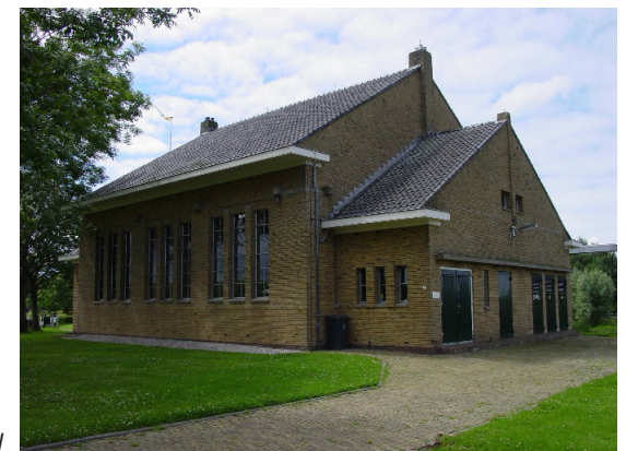
gemaal bij Ezumazijl
