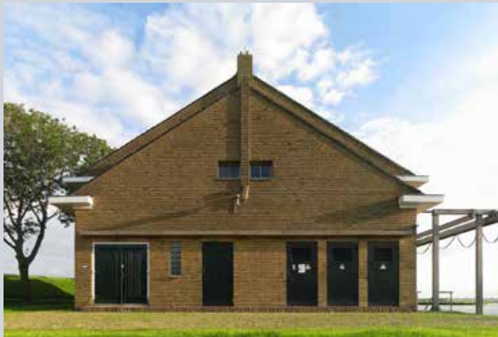
Afb.6.11b Het gemaal Dongeradielen werd in 1931 gebouwd aan de zuidzijde van de spui- en keersluis de Ezumazijl. Over de sluis ligt deze ophaalbrug. Net als veel ander sluizen, molens en gemalen zijn de sluis, de brug en het bijbehorende bedieningsgebouw eigendom van Stichting Waterschapserfgoed, die zich inzet voor het behoud ervan.
