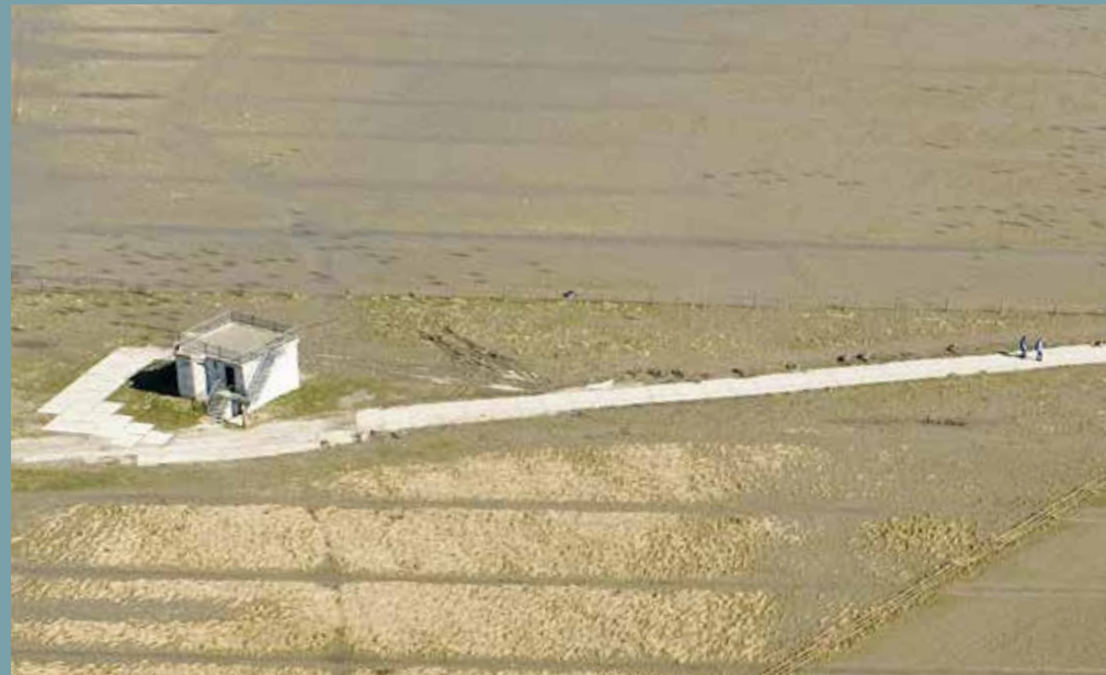
Afb.5.25 In het Noarderleech staat een klein bunkertje dat tijdens de oorlog als waarnemingspost werd gebruikt. Tegenwoordig dient het als uitzichtpunt.
