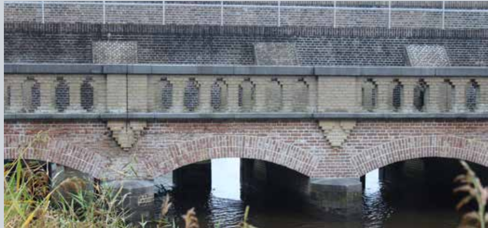
Afb.6.11c De keersluis Munnekezijl werd in 1882 gebouwd. In Munnekezijl lag toen reeds een oude sluis uit 1714 die in een bocht van de rivier De Lauwers was aangelegd. De huidige brug met keersluis ligt in de Munnekezijlsterried. De sluis diende voor de waterafvoer van de Friese boezem naar de Lauwerszee. De bocht in De Lauwers werd door het graven van een stroomkanaal afgesneden.
