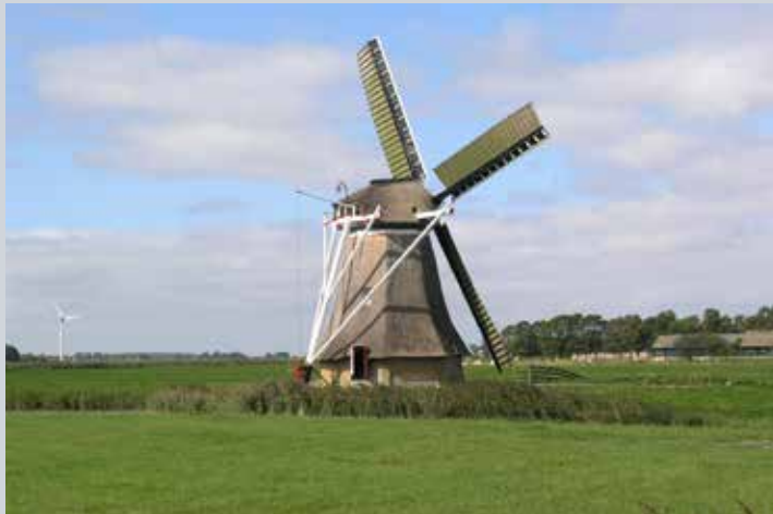
Afb.6.11a De Miedenmolen bij Holwerd werd in 1855 gebouwd voor de bemaling van de polder Dwergsmear en is tegenwoordig eigendom van Stichting de Fryske Mole. De molen kan in geval van wateroverlast nog steeds worden ingezet voor de bemaling van de Holwerd- en Blijaërpolder.
