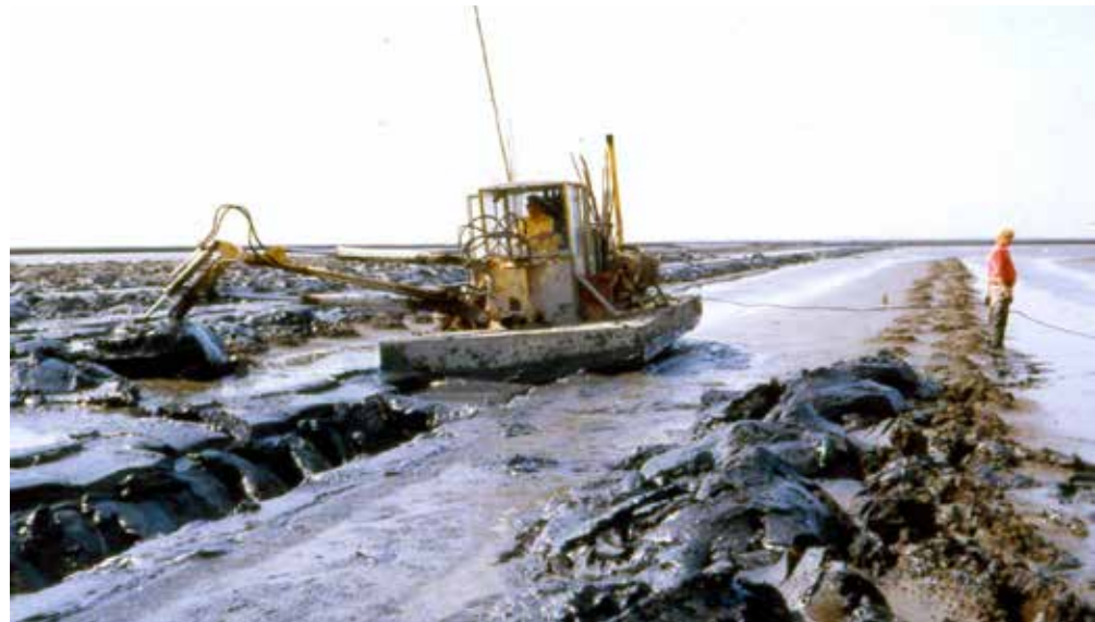
Afb.5.15 Graafpontoon van de firma Delta Bouw uit Holwerd bezig met het slatten van de greppels en het ophogen van de akkers. Op deze manier werd jaarlijks een derde van de bezinkvelden gegraven, na drie jaar waren de greppels weer gevuld met slib.
