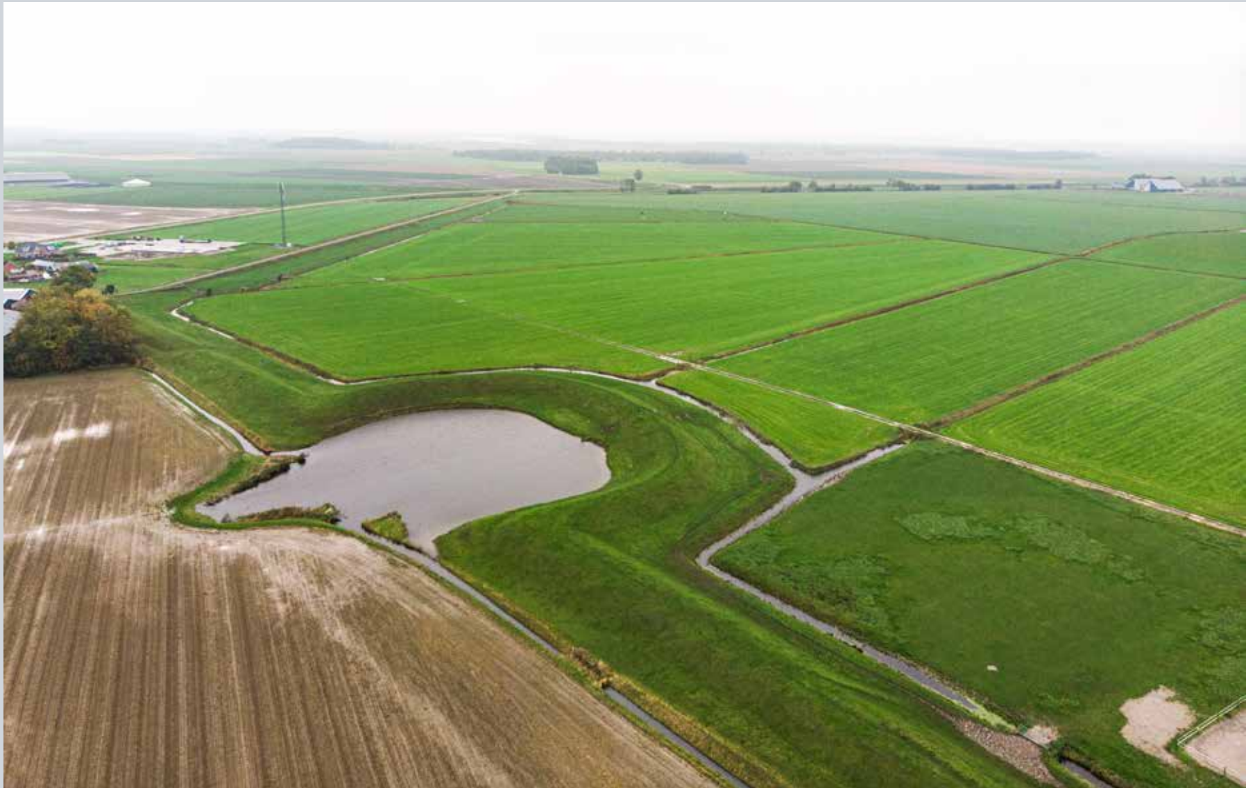
Afb.4.29 Langs de zee en de bedijkte kweldergeulen zoals het Dokkumer Grutdijp hebben diverse keren dijkdoorbraken plaatsgevonden. Door de schurende werking van het water werden daarbij zeer diepe wielen of kolken uitgeschuurd. Vervolgens werd de dijk landinwaarts of zeewaarts verlegd: de wielen werden buiten- of binnengedijkt. De Sânwielen zijn voorbeelden van dijkdoorbraken, maar ook het binnengedijkte wiel zichtbaar op de foto in de Olde Dyk bij Munnekezijl.
