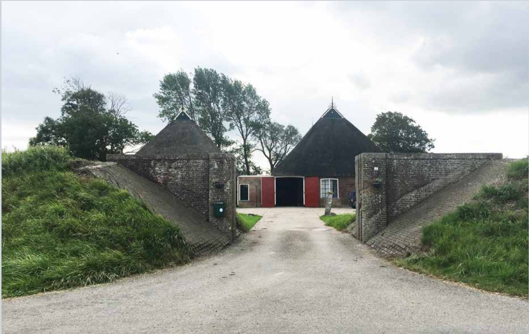
Afb.4.27 Een dijkcoupure is een doorsnijding van de dijk ten behoeve van het verkeer. Dat gebeurde vaak bij de aanleg van nieuwe zeepolders. Dijkcoupures bestaan vaak uit een gemetselde of betonnen dijkwand met aan weerszijden uitsparingen. Daar konden bij dreiging van hoogwater balken in worden geschoven. Op de foto is een dijkcoupure te zien van de Alddyk tussen Anjum en Paesens.
