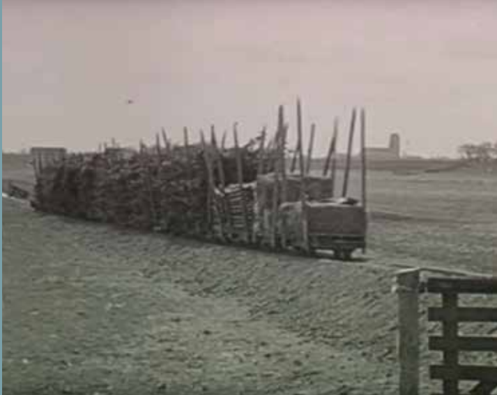
Afb.5.14 De film 'van Waddenzand tot vruchtbaar land' uit de jaren '50 geeft een prachtig beeld van de werkzaamheden op het wad
