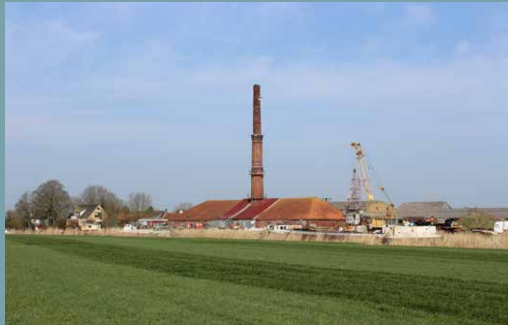
Afb.4.36 De steenfabriek bij Oostrum.
