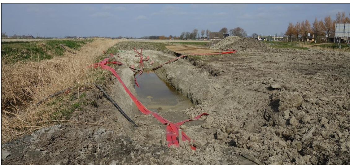
Figuur 10: Op het terrein liggen enkele metalen platen, is een sleuf gegraven en liggen wat bergen zand.
