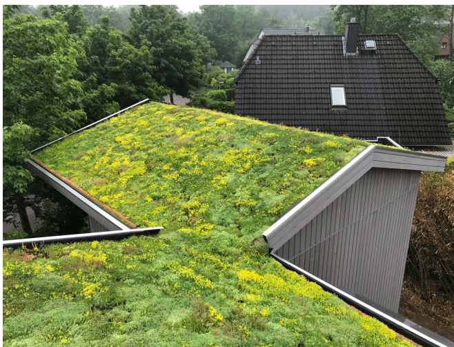
Vegetatiedak op bijgebouw
