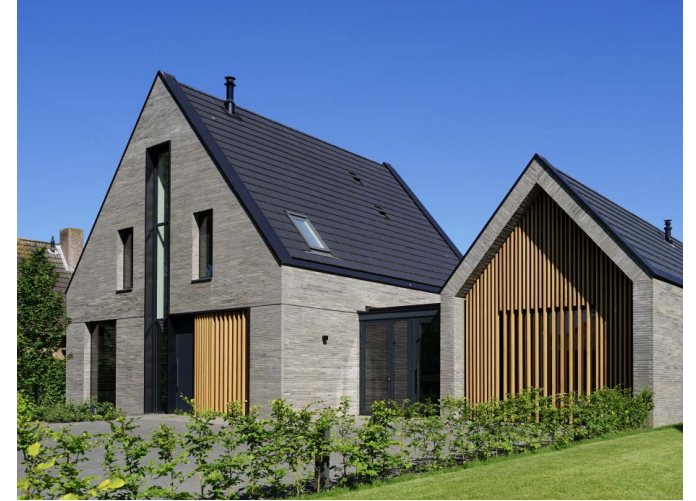
Gevels in licht metselwerk met lichte en donkere accenten
