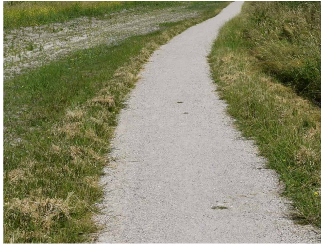
Referentiebeeld halfverharding oost-westwandelpad
