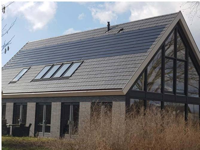
Voorbeeld inpassing zonnepanelen in het dak
