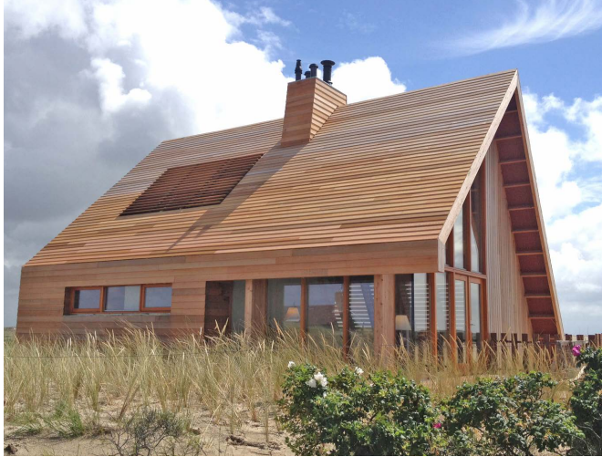
Gevels en dak in licht hout
