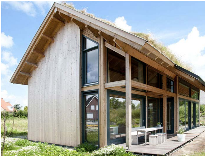
Gevels in licht hout, vegetatiedak en forse overstekken
