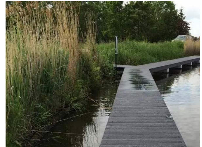
Per woning is een steiger toegestaan 'los' van de oever
