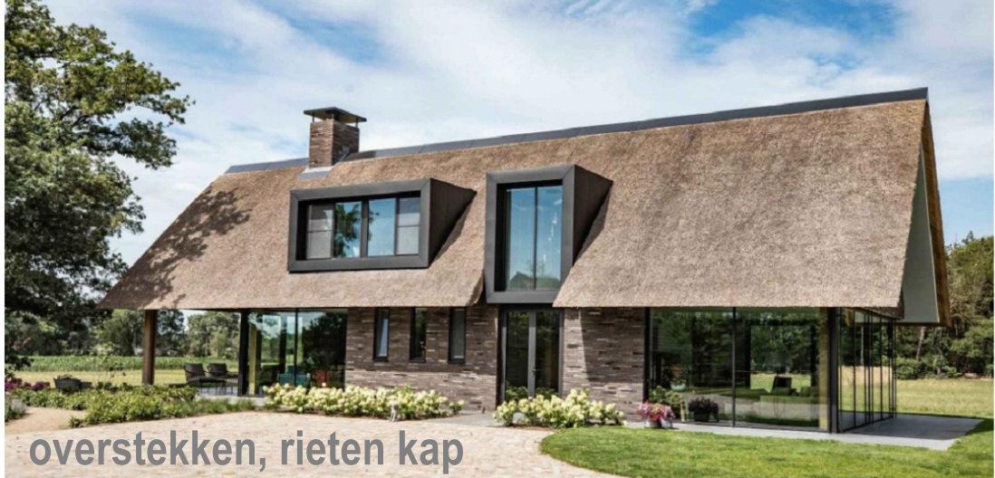
overstekken, rieten kap
