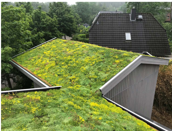
Vegetatiedak op bijgebouw
