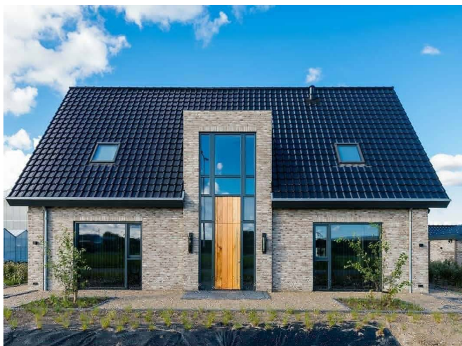
Gevels in lichte baksteen
