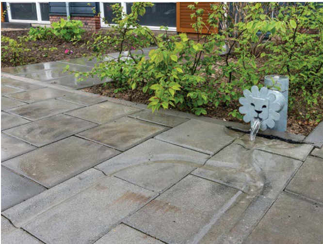
Regenwater wordt afgekoppeld en zichtbaar afgevoerd Bron: Struykverwoinfra.nl
