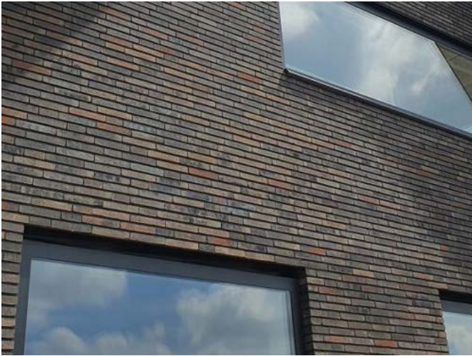
Gevels in donkere baksteen Bron: Steenhandel-twenthe.nl
