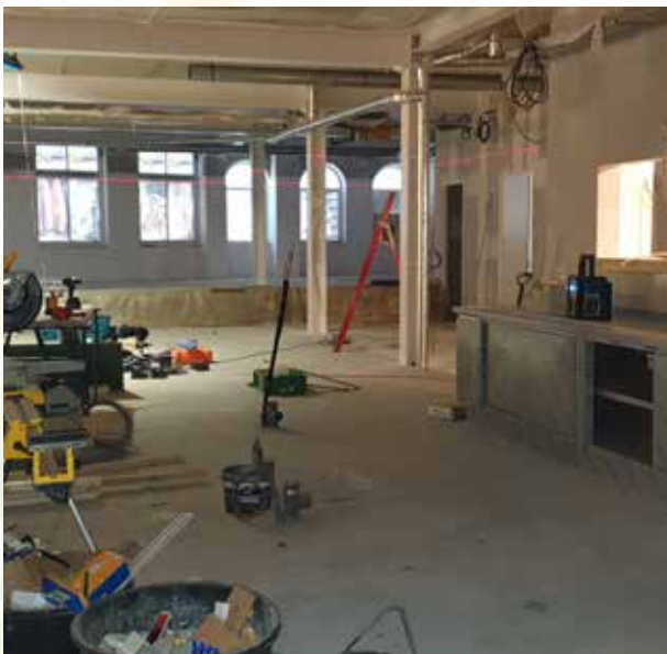
Figuur 6. Bouwwerkzaamheden binnen(noordoost)zijde.
