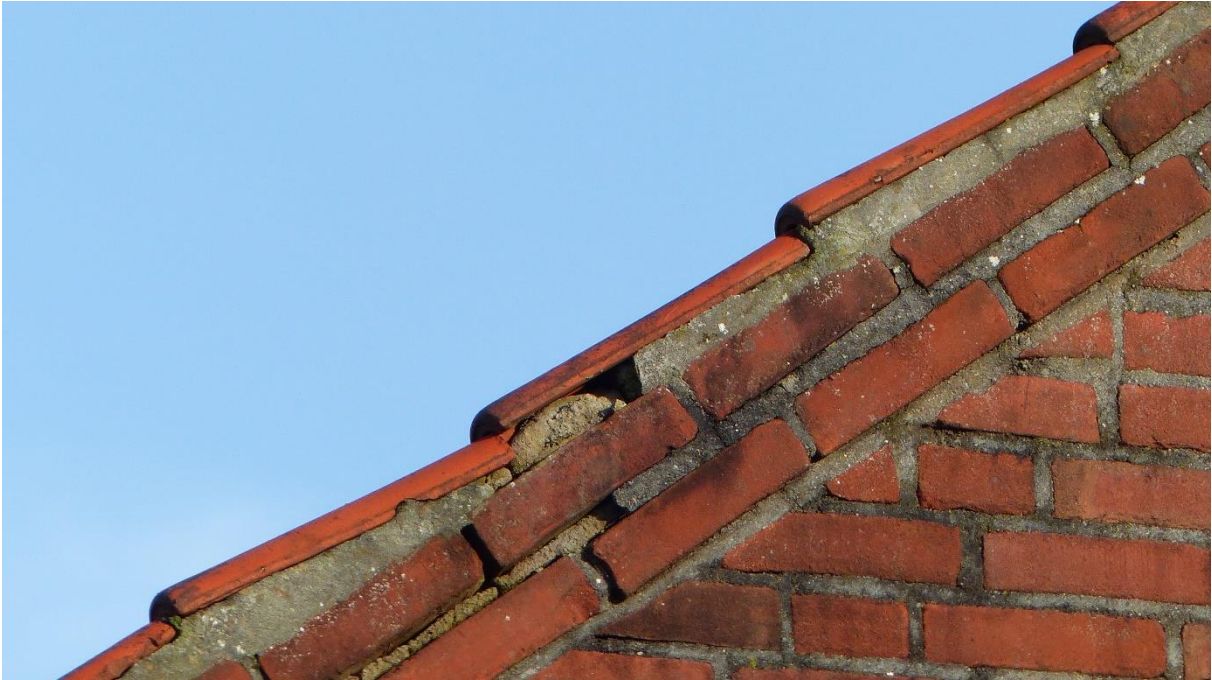
Figuur 4.1 Ruimte onder de kantpannen waar gierzwaluwen toegang krijgen tot het dak.
