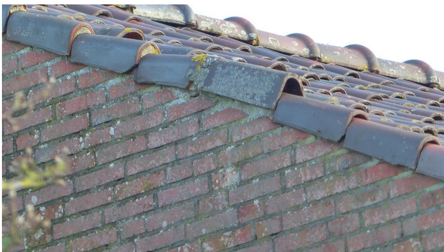
Figuur 4.7 Er bevindt zich ruimte onder de kantpannen.
