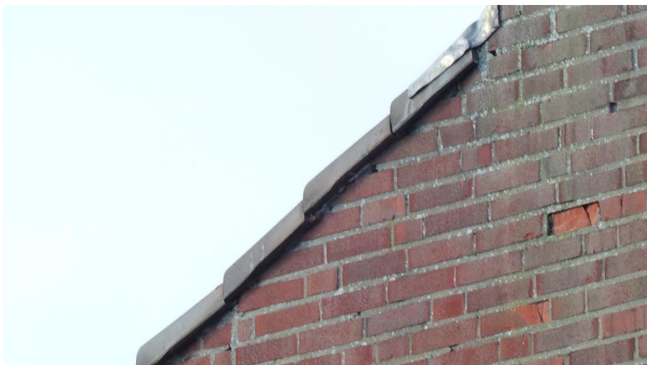
Figuur 4.6 Ruimtes onder de gevelpannen kunnen toegang bieden tot de spouw/daklaag.
