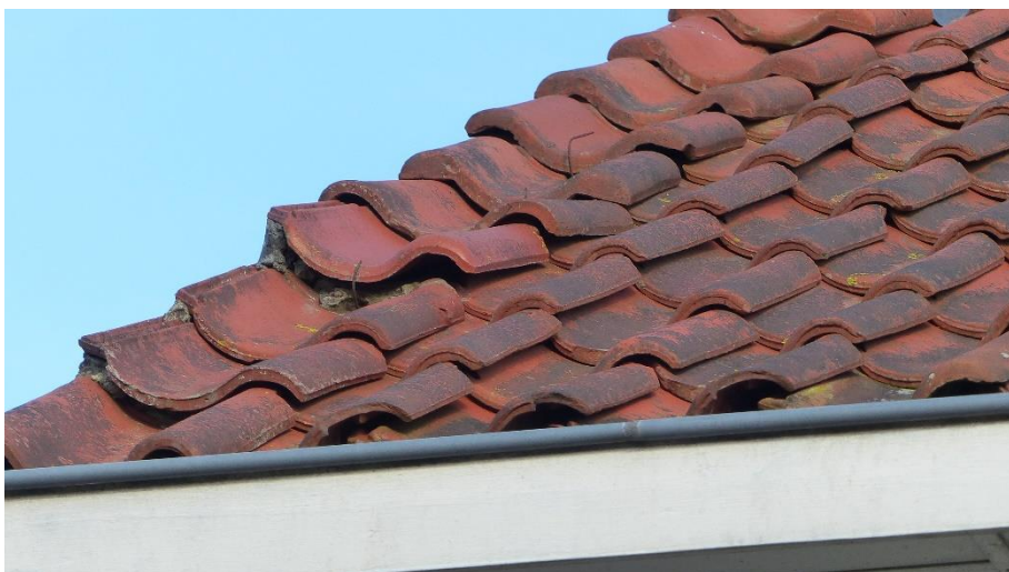
Figuur 4.8 Er bevindt zich ruimte onder de dak- en kantpannen.
