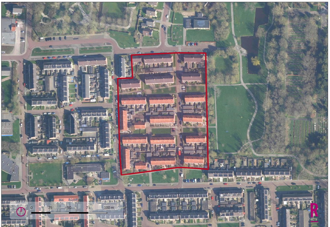
Figuur 1: Luchtfoto huidige situatie
