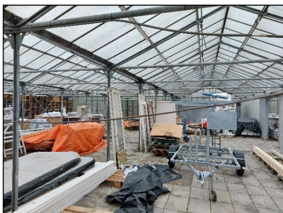
Afbeelding 2.6. Opslag van verschillende materialen in kassen.
