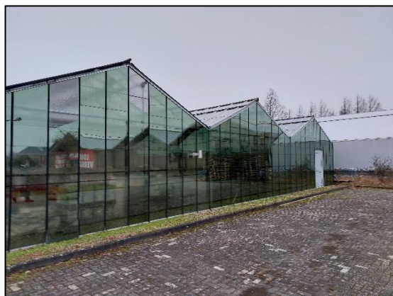
Afbeelding 2.5. Aanbouw van glazen kassen.
