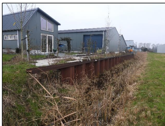
Afbeelding 2.19. Woning en bedrijfspand ten oosten van plangebied.
