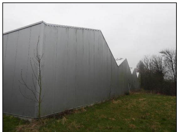
Afbeelding 2.3. Achterkant van de loods met metalen wanden.
