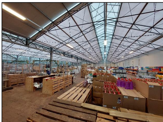
Afbeelding 2.4. Loods is in gebruik voor verkoop.
