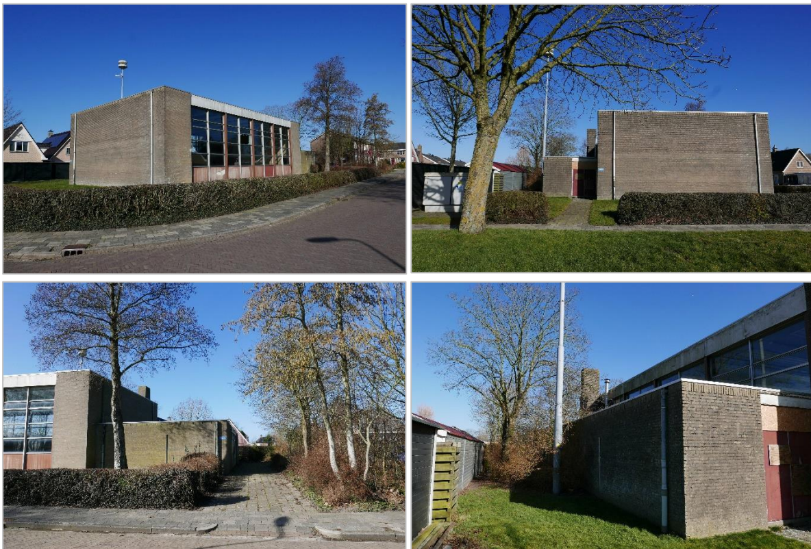
Afbeelding 2. De te slopen voormalige gymzaal aan De Terp 22 in Blije.
