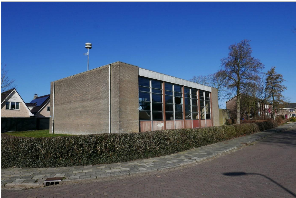
Gymzaal vanaf kruising De Terp en Johannes Doornbosstrjitte. Foto richting noordwesten.
