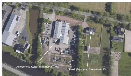
Figuur 1a Bestaande situatie Simmerwei 15
