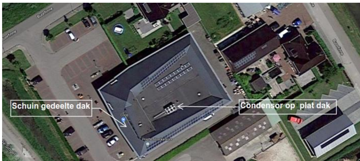
Afbeelding 2: Condensor op plat dak met rondom schuine dakrand
