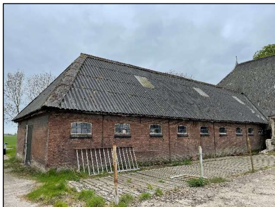
Stal met asbest dak.
