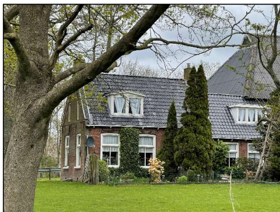
Voorhuis met dakkapel en dakpannen.
