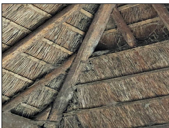
Afbeelding 2.7. Rieten dak delen van binnenuit gezien.
