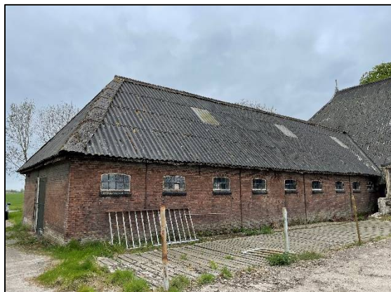
Afbeelding 2.4. Stal met asbest dak.
