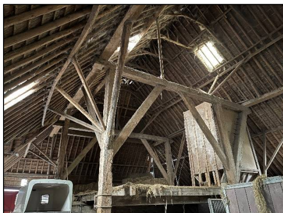
Afbeelding 2.6. Asbest deel stal van binnenuit gezien
