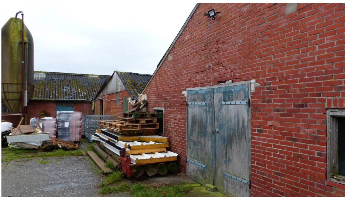
Figuur 1.6 Voorzijde varkensstallen, gezien in zuidelijke richting.
