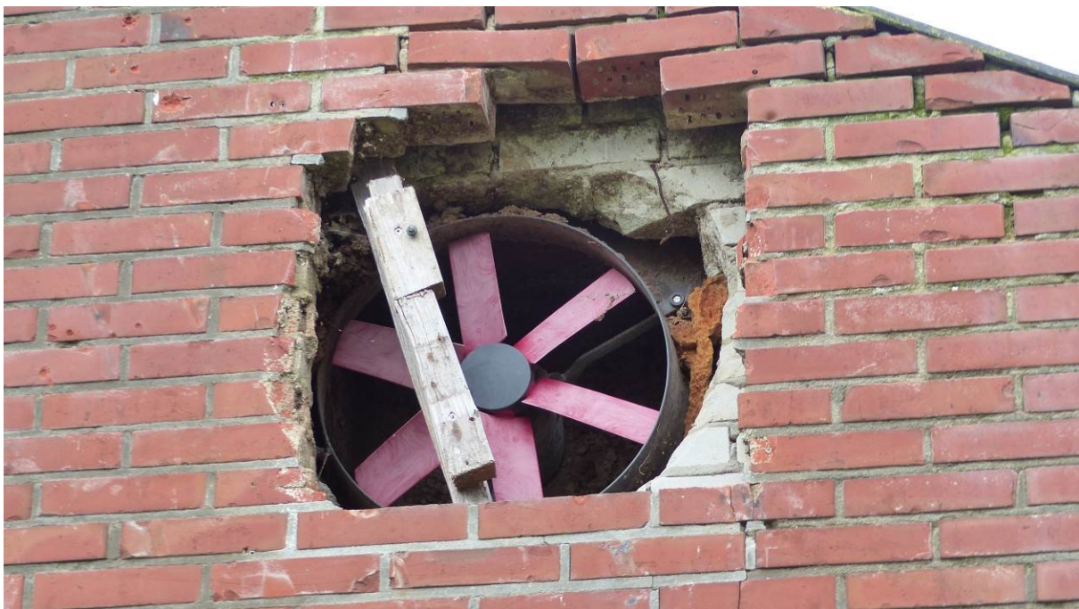
Figuur 4.5 Vleermuizen kunnen via de opening bij de ventilatie in de spouw komen.
