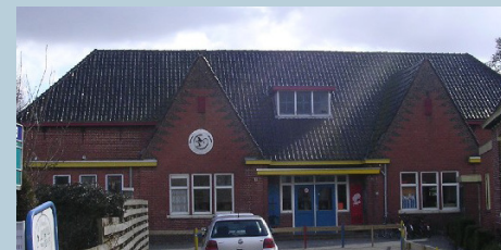
Hoofdstraat 226 Oostwold Christelijke basisschool oorspronkelijk uit 1918. In de jaren twintig of dertig van de twintigste eeuw in grijpend verbouwd en vergroot. Ensemble met schoolmeesterswoning en naastgelegen woning die ook worden aangewezen als karakteristiek. De school staat op ruime afstand evenwijdig aan de weg met daarvoor een schoolplein. Beeldbepalend gelegen als onderdeel van een complex aan de doorgaande weg ten westen van de bebouwde kom van Oostwold. Vooral van architectuurhistorische waarde vanwege de uitbouw in markante Amsterdamse school-stijl.
