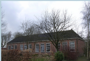
Haspelwijk 3 Zevenhuizen Voormalige openbare school uit 1888 thans in gebruik als woonhuis. Rechthoekige plattegrond met schilddak en grote vensters met roede verdeling aan de oostzijde. Beeldbepalend gelegen aan een kruising. Ensemble met naastgelegen schoolmeesterswoning. De school staat op enige afstand van de weg en is gelegen nabij de kruising van Haspelwijk met Oudewijk. Van hoge cultuurhistorische waarde vanwege de belangrijke maatschappelijke functie.
