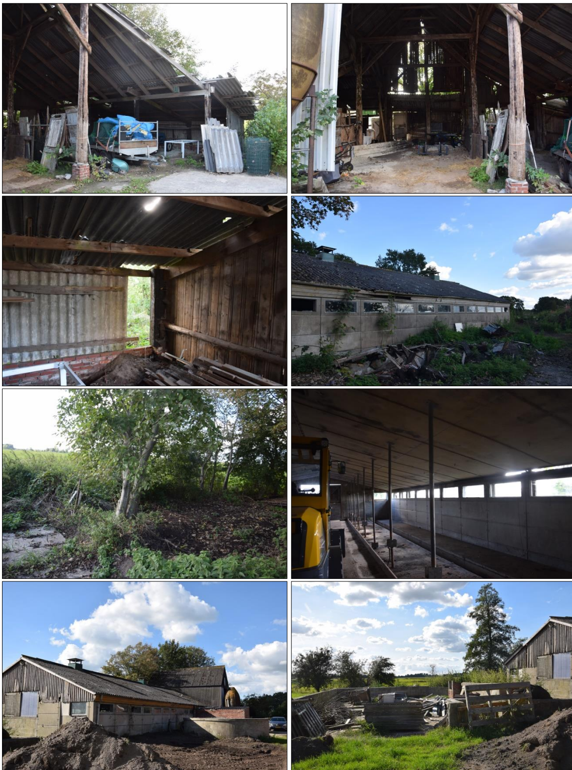
Foto's 1 tot en met 8. Impressie van het plangebied met de te slopen bebouwing en silo's op 21 september 2022.
