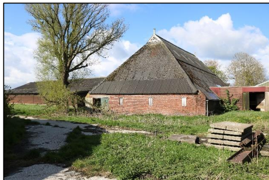
Afbeelding 2.5. Te slopen stallen, gezien vanaf oosten.
