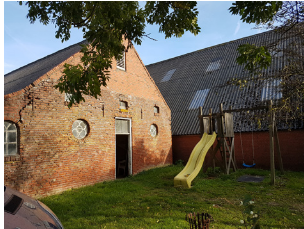
2. aan woning gebouwde schuren met asbestdaken
