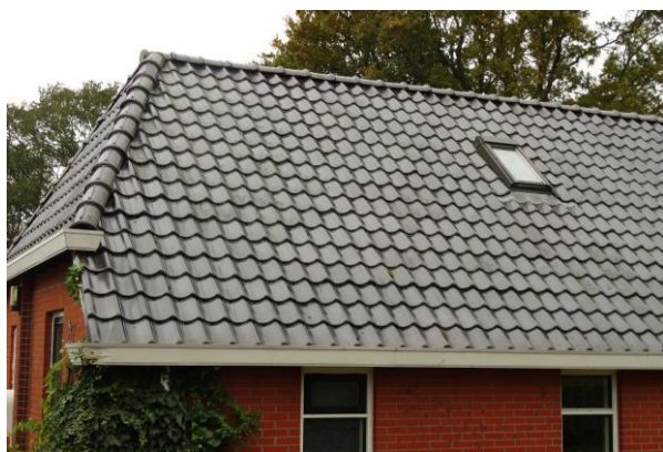
Figuur 10: De pannen liggen strak op het dak.
