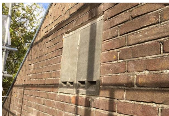
Figuur 15: Een voorbeeld van de ANS-6 kast in een gevel ingebouwd. (bron: veldshop.nl)
