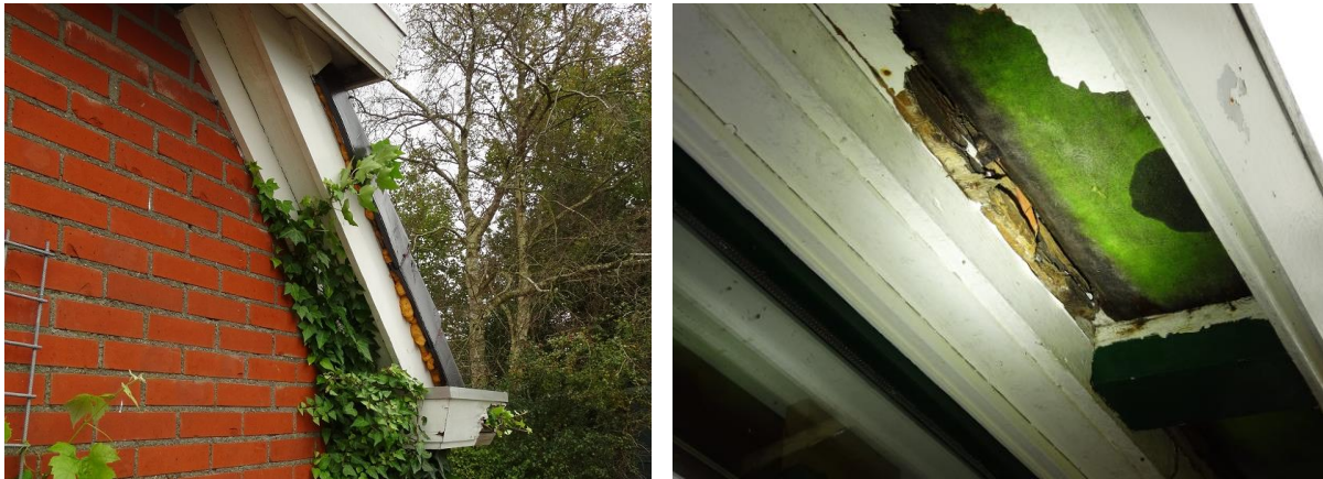
Figuur 13 en 14: Eventuele ruimte onder de kantpannen en onder de houtrot van de dakgoot zijn gedicht.
