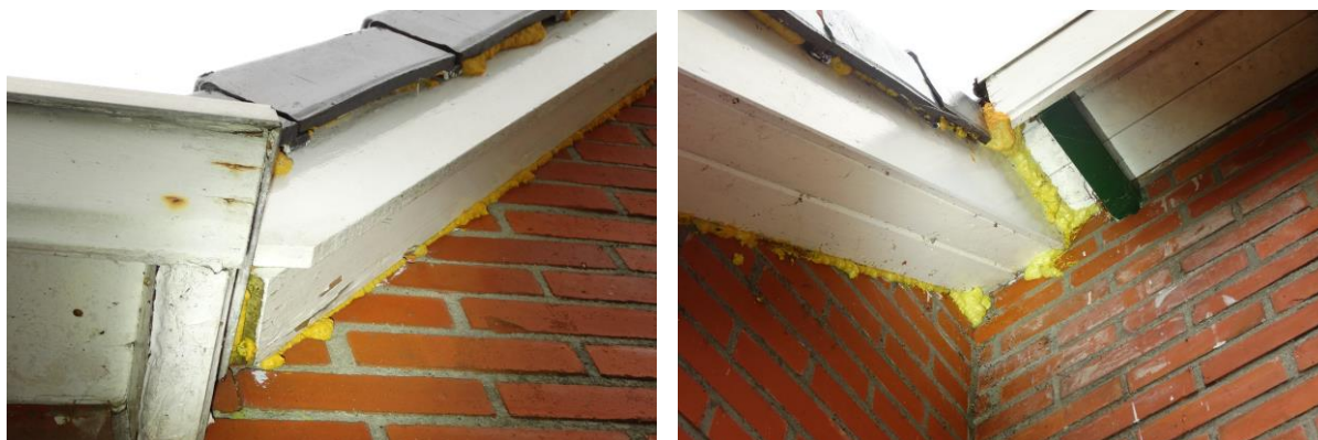
Figuur 11 en 12: Rondom de woning zijn voor vleermuizen geschikte uitvliegopeningen gedicht.
