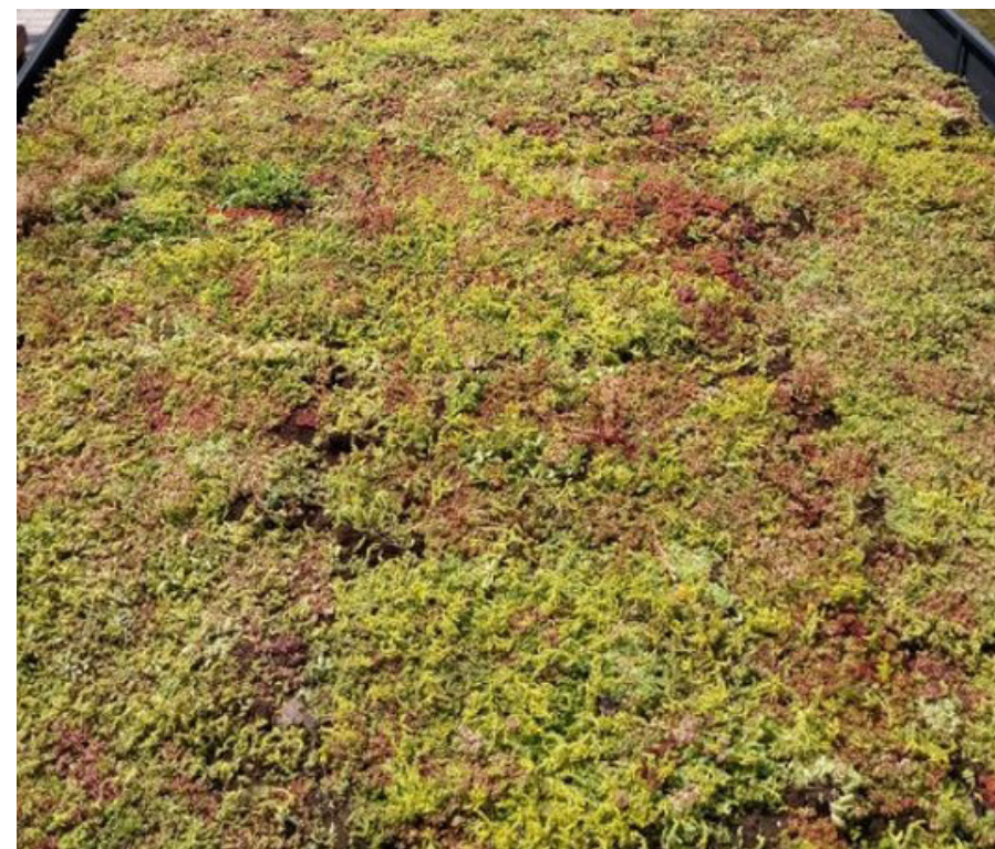
Bergingen blok voorzien groendak
