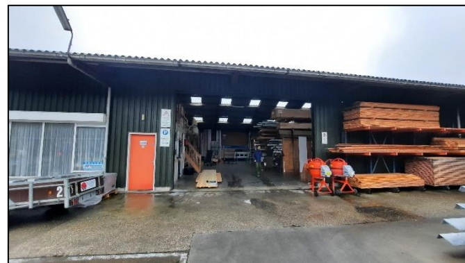
Afb. 10: deuropening loods (geluid vanwege platenzaag/afkortzaag)
