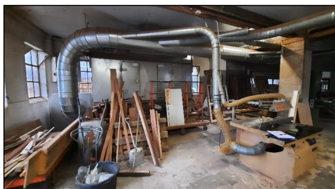
Afb. 8: werkplaats westzijde met afzuiginstallatie
