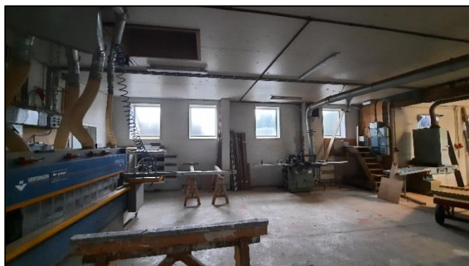
Afb. 9: Z-gevel werkplaats met ramen van draadglas
