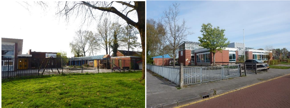
Figuur 2 Het schoolgebouw is onderzocht op gebruik door huismussen en vleermuizen. Foto's: Bureau Biota.
