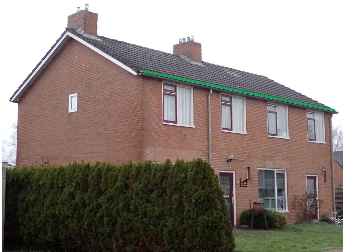
Figuur 5 Plekken met kansen voor huismussen om zich toegang te verschaffen tot het dakvlak onder de dakpannen (zie groene lijnen). Foto: Bureau Biota.
