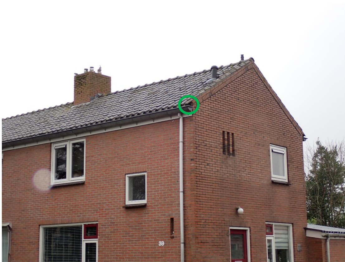
Figuur 5 Plekken met kansen voor gierzwaluwen om zich toegang te verschaffen tot het dakvlak onder de dakpannen (zie groene cirkels). Foto: Bureau Biota.
