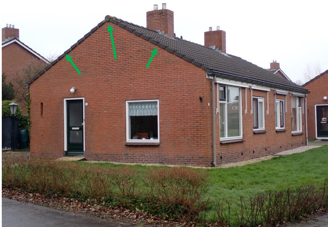
Figuur 6 Wegkruipmogelijkheid voor vleermuizen tussen de kantpannen en ruimte bij de loodslab en de nokpannen van een van de woningen. Foto's: Bureau Biota.
