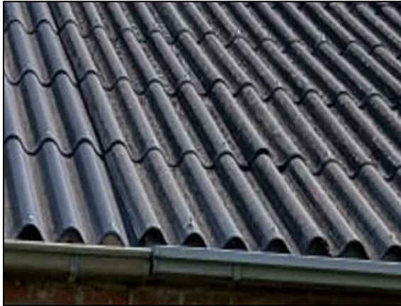
Onder de golven van de golfplaten zijn plaatjes bevestigd.
