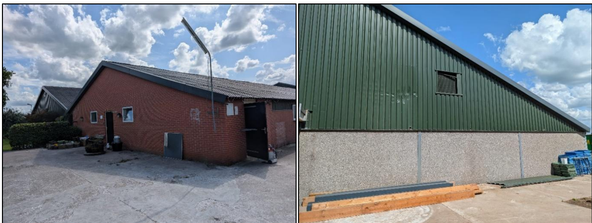
Foto links; strak aansluitende daklijsten (gezette profielen) tegen metselwerk. Foto rechts; prefab gevelplaten zijn niet toegankelijk en daarom ongeschikt voor vleermuizen.
