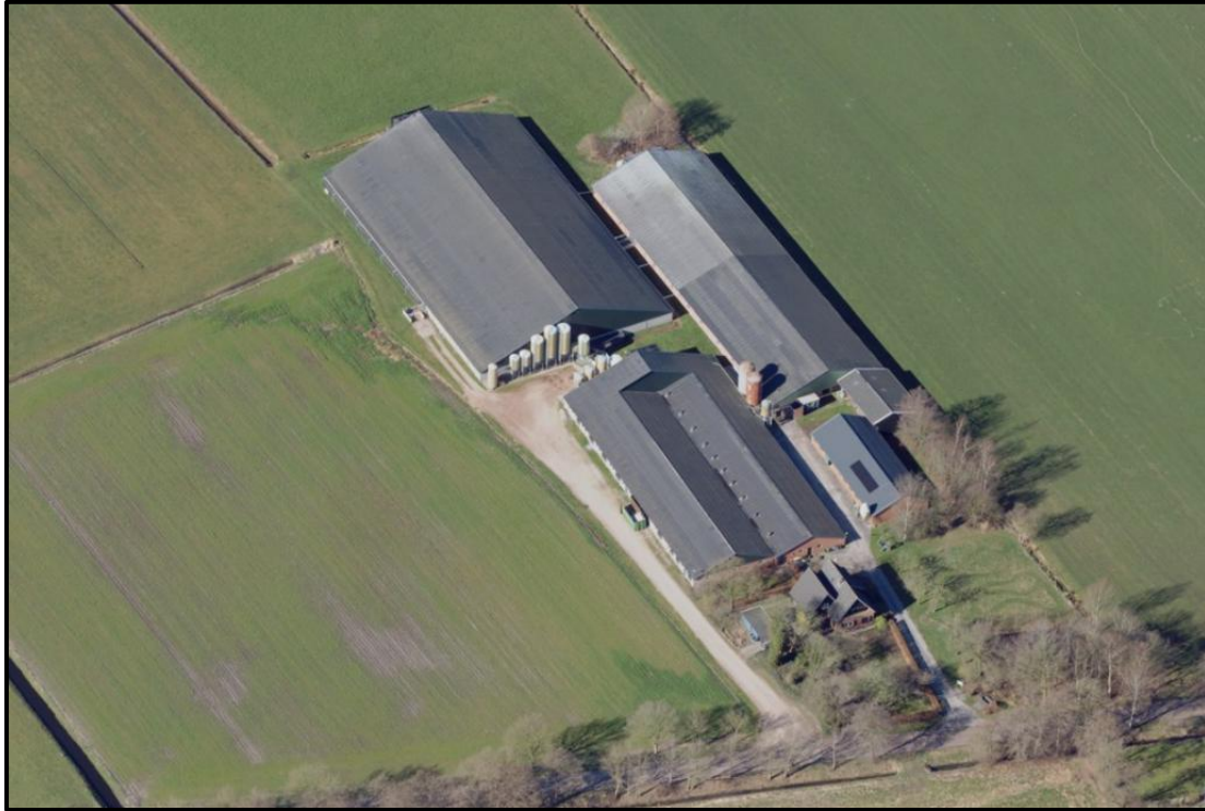
Figuur 1: Luchtfoto perceel Keuningsweg 37 te De Wilp Gn. (bron: Streetsmart.cyclomedia.com)
