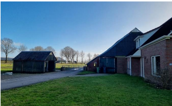
Figuur 13: Links, kijkend in zuidelijke richting, v.l.n.r. gebouw A, gebouw B en de woning. Rechts, de kapschuur vanaf de oprit kijkend in zuidwestelijke richting.
