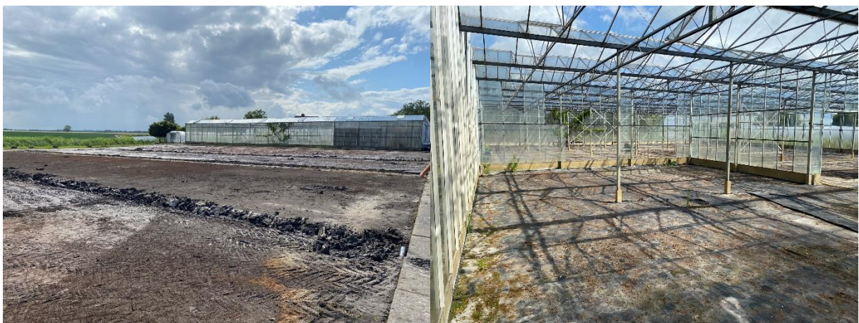
Afbeelding 2. De te slopen kassen gezien vanuit het westen (links) en de binnenzijde van de kassen (rechts).
