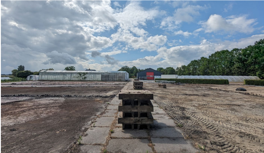
De af te breken kas, met daaromheen de plastic kassen en het al deels opgeruimde plastic zeil. De loods met de rode deur blijft behouden.
