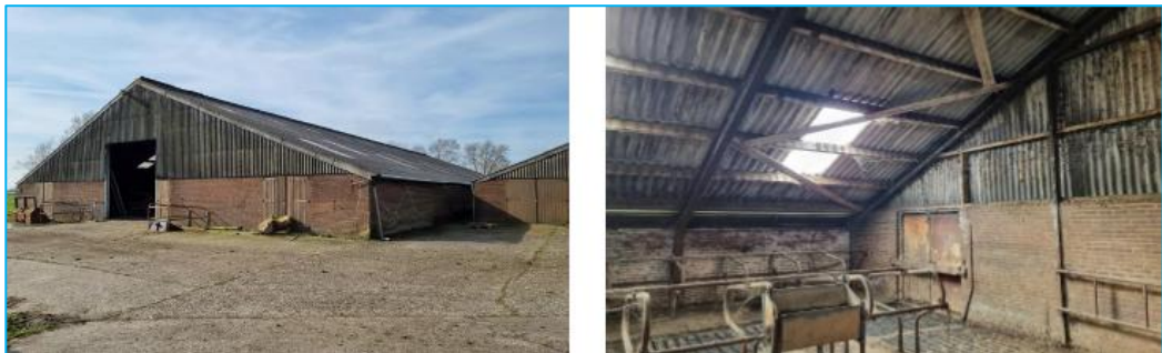
Links, object D van de buitenkant gezien. Rechts, zicht op een stukje van de binnenzijde van de voormalige ligboxstal.
