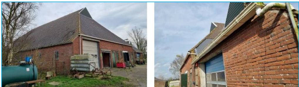
Links, de kapschuur, met gemetselde muren en pannendak. Rechts, de aanbouw naast de kapschuur
