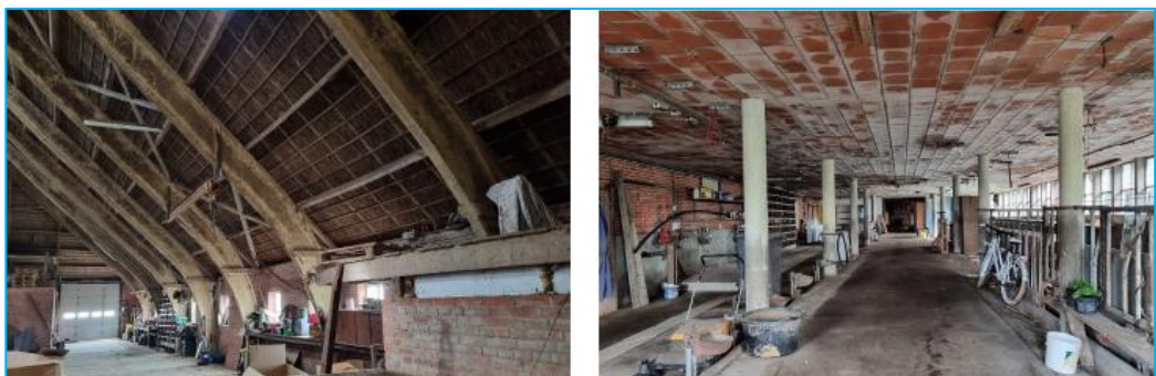
Links, de binnenzijde van de kapschuur. Rechts, de binnenkant van de kapschuur.
