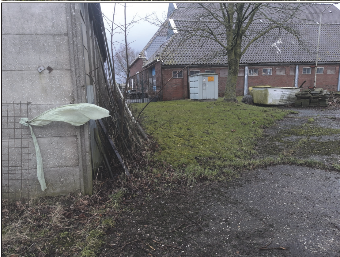
Voormalige brandstofopslag en druppelzone
